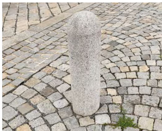
obr. 136 Preferovaný vzhled zahrazovacích sloupků — kamenný ze světle šedé žuly bez vizuálního kontrastu.
