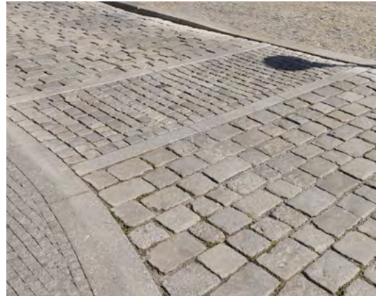
obr. 92 Pruh z drobných kostek usnadňuje chůzi i jízdu na invalidním vozíku přes vozovku dlážděnou historickou dlažbou s širokými spárami. Vhodnějším řešením je však použití hladké formátové dlažby B.2.2.b.
