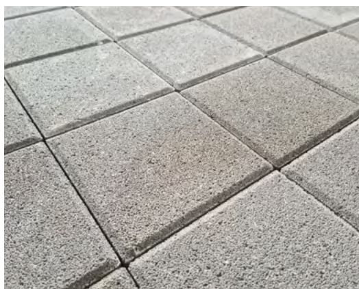
obr. 31 dlažba z vodopropustného betonu B.3.2.e šedá
