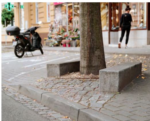
obr. 139 — Palackého třída Ochrana stromu je zajištěna obrubou a kamennými zahrazovacími bloky.
