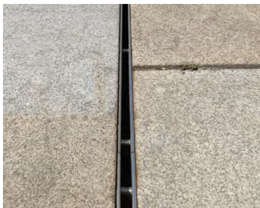
obr. 147 Doporučená podoba nerezové štěrbinové vpusti.
