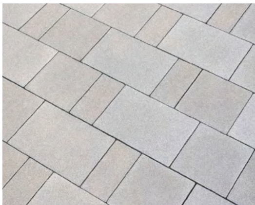
obr. 27 skladebná dlažba tryskaná B.3.2.a beton, světle šedá
