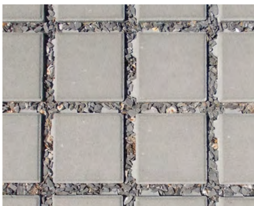
obr. 30 distanční dlažba B.3.2.d beton, světle šedá
