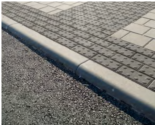
obr. 37 betonový obrubník B.3.5.b
