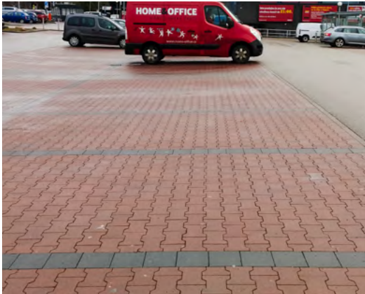
obr. 69 Správně provedená bezfasetová dlažba odolá intenzivnímu provozu automobilů.
