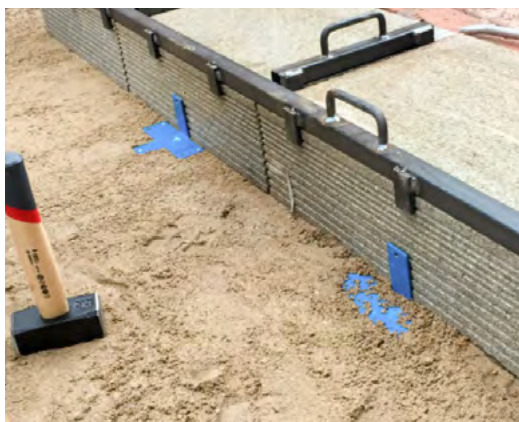
obr. 74 Kotva VERSCHI vario+ od společnosti NUPFAHL.
