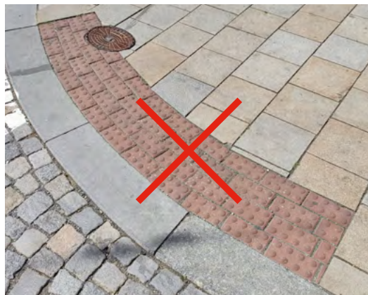
obr. 53 Nepřipustné použití hmatné dlažby červené barvy. V kategoriích A a B není přípustné použití betonových prvků (platí i pro hmatnou dlažbu).
