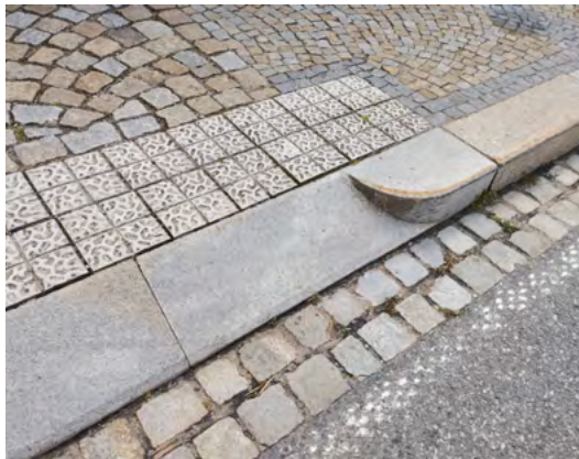
obr. 17 nájezdový obrubník přímý a přechodový B.2.7.c žula, světle šedá
