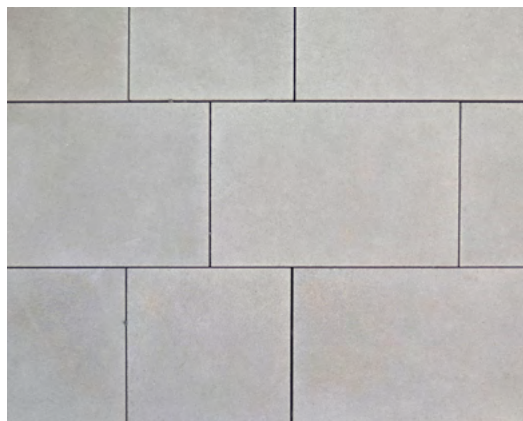
obr. 28 skladebná dlažba tryskaná B.3.2.b beton, světle šedá
