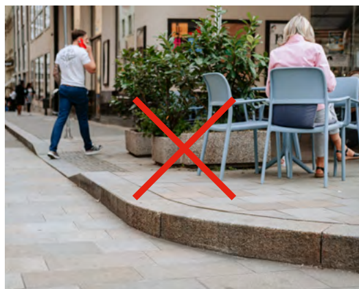
obr. 87 — ul. Kozí V ulicích centra města, kde je zvýšený pohyb chodců, jsou zvýšené obrubníky spíše překážkou než ochranou před provozem.
