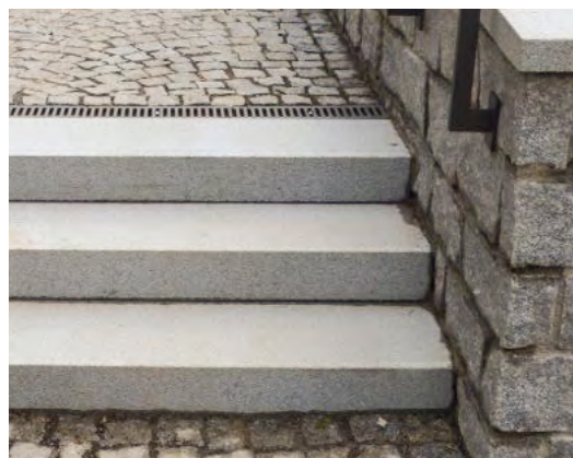
obr. 12 schodišťové stupně tryskané B.2.5 žula
