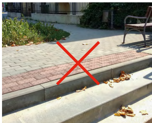
obr. 55 — ul. Pellicova Vytváření schodišťových stupňů z obrubníků není v MPR Brno přípustné.
