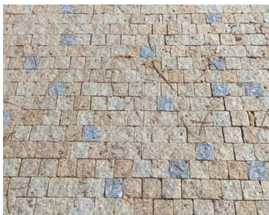
obr. 5 — ul. Husova mozaika, boky řezané B.2.3.a žula, 6 × 6 × 6 cm, světle šedá a žlutá
