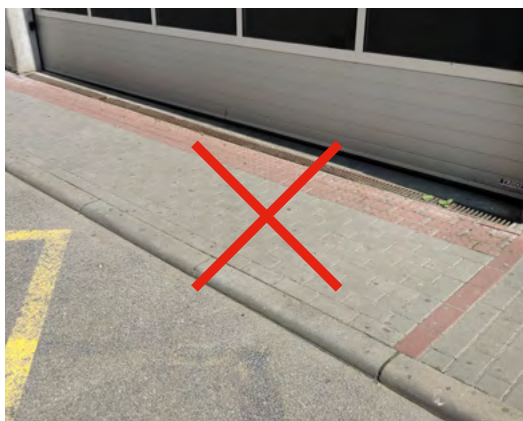
obr. 54 Zvýraznění vjezdu do objektu červenou dlažbou je v MPR Brno nepřipustné (platí pro samostatné sjezdy přes chodníkový přejezd).
