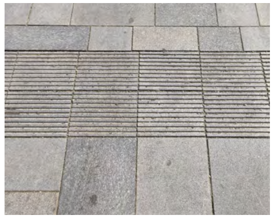
obr. 90 Správně vyřešený detail lemování hmatné dlažby umělé vodící linie.
