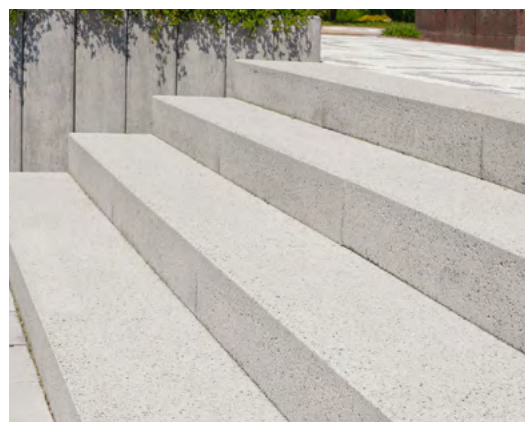
obr. 32 monolitické schodišťové stupně tryskané B.3.3 beton, světle šedá
