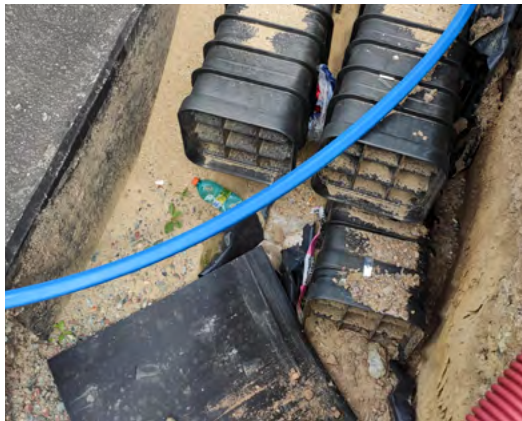
obr. 58 Realizace multikanálu ve výkopu.
