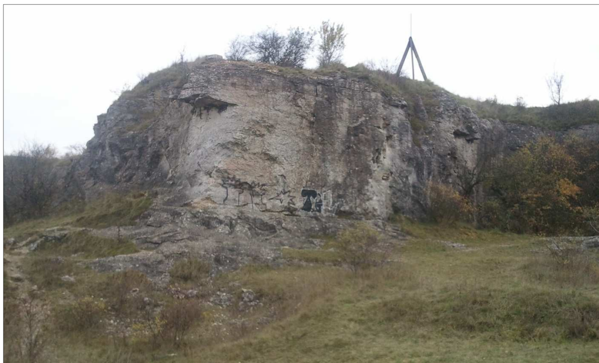
Obr. 70 Fotodokumentace, partie v horní části lokality
