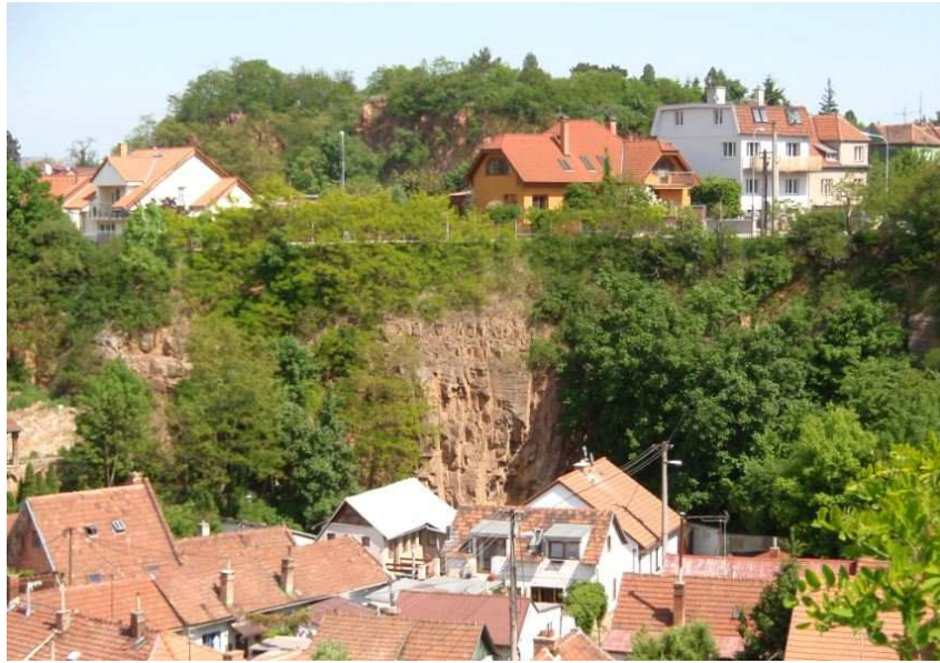
Fotografie č. 1 : Celkový pohled horní část skalní stěny nad Kamennou čtvrtí v Brně - Štýřicích. Pod skalní stěnou po opuštění lomu pokračovala chaotická výstavba rodinných domků (bez odkanalizování) . Foto P. Voda, srpen 2011.
