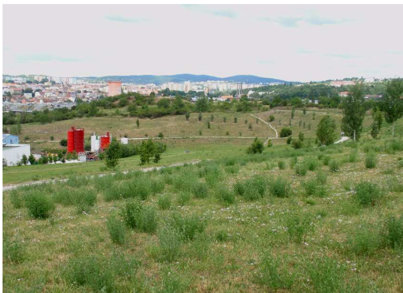
Fotografie č. 2 : Celkový pohled na odlučnou oblast aktivního sesuvu a střední část svahu nad ulicí Sportovní v Brně - Králově Poli. V patě svahu pod akumulací sesuvu se nacházejí objekty OC Tesco (vlevo dole). Foto P. Voda, červenec 2014.
