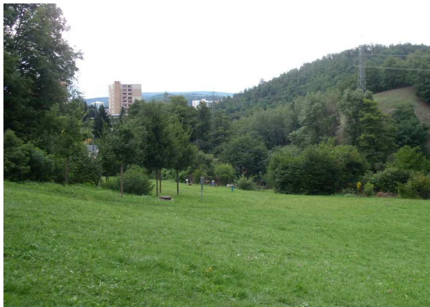
Fotografie č. 1 : Celkový pohled na sanovanou část svahu pod ulicí Černého v Brně - Bystřici. Tato část svahu byla sanována již v době výstavby sídliště. Svah byl dále osazen monitorovacími sondami. Foto P. Voda, srpen 2014.
