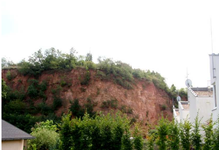
Fotografie č. 1 : Celkový pohled na závěrnou skalní stěnu nad ulicí Kamenná kolonie v Brně - Štýřicích. Pod skalní stěnou v opuštěném lomu byly v roce 2005 postaveny nové řadové rodinné domy. Foto P. Voda, srpen 2011.
