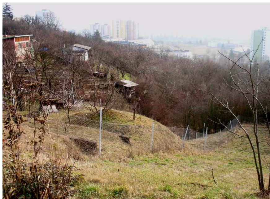
Fotografie č. 4 : Pohled na výraznou odlučnou oblast rizikového sesuvu nad ulicí Petra Křivky v Brně - Novém Lískovci (zřetelné poklesy a deformace terénu). Foto P. Voda, stav březen 2014.
