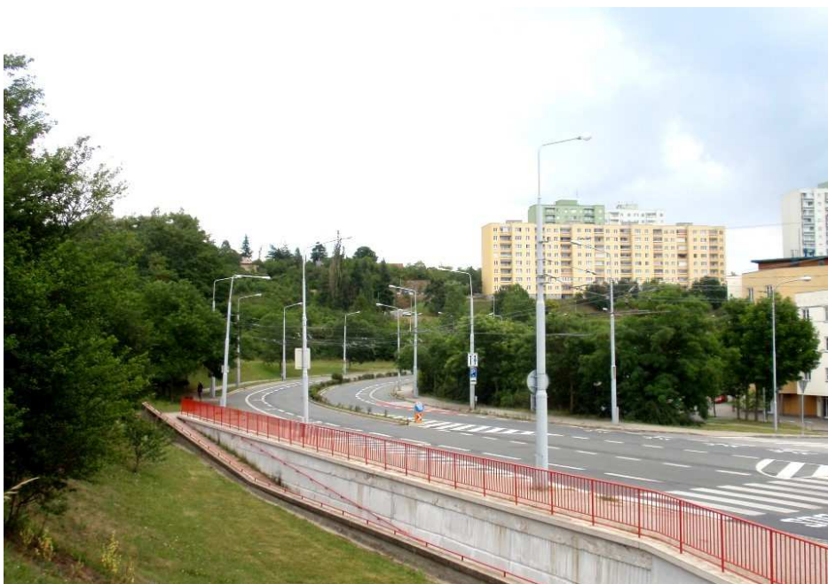
Fotografie č. 1 : Celkový pohled na střední část sesuvného území nad ulicí Petra Křivky v Brně - Novém Lískovci. Terén v patě svahu byl upravován při výstavbě komunikace a bytových domů. Foto P. Voda, stav červenec 2014.
