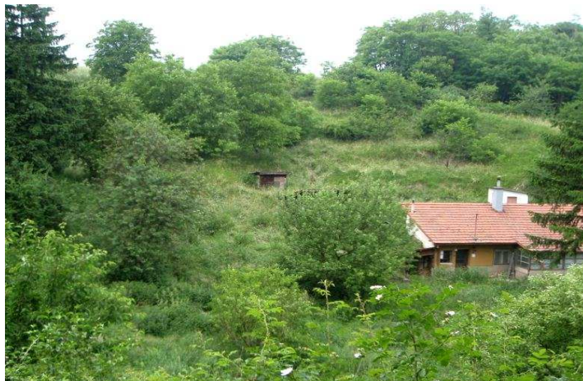
Fotografie č. 2 : Pohled na vytěžený prostor hliníku bývalé cihelny s výstavbou rodinných domů v prostoru pod odlučnou oblastí sesuvu nad ulicí Velatickou v Brně - Líšni. Foto P. Voda, květen 2011.
