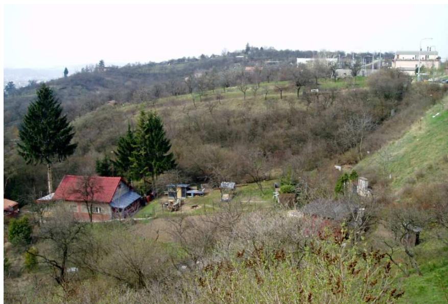
Fotografie č. 1 : Celkový pohled na horní část sesuvného území pod ulicí Věstonickou v Brně - Vinohradech. V odlučné oblasti sesuvu se nacházejí sprašové hlíny, jílovité hlíny a jíly. Foto P. Voda, duben 2011.
