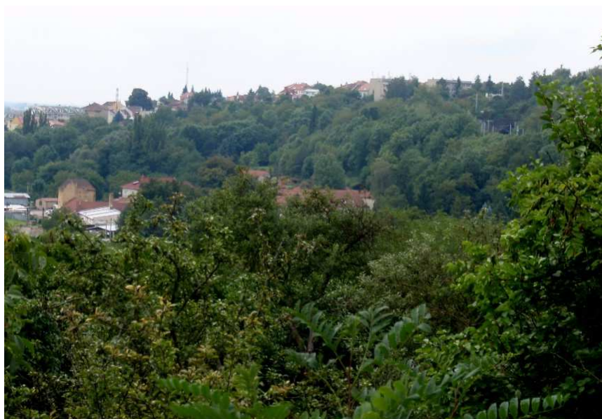
Fotografie č. 2 : Celkový pohled na odlučnou oblast sesuvného svahu nad ulicí Zázmolí v Brně – Obřanech. Foto P. Voda, srpen 2014.
