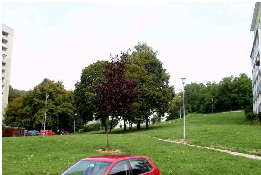
Fotografie č. 2 : Pohled na akumulční oblast sesuvu v Brně – Žabovřeskách pod Palackého vrchem nad ulicí Bochořákovou. Akumulační oblast sesuvu zasahuje až k panelovým bytovým domům.
