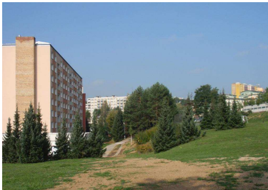
Fotografie č. 1 : Celkový pohled na sesuvem postiženou část svahu pod ulicí Štouračovou v Brně - Bystřci. Tato část svahu byla sanována v rámci výstavby sídliště. Foto P. Voda, září 2012.
