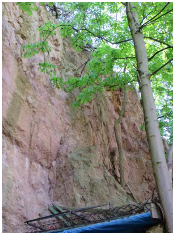
Obr. 2. Skalní stěna rozvolněná kořenovým systémem náletových rostlin. Foto H. Gilíková, duben 2015.
