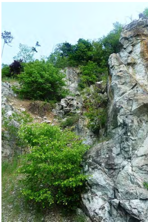
Obr. 7: Střední část severovýchodní stěny lomu (foto A. Havlín, květen 2015).
