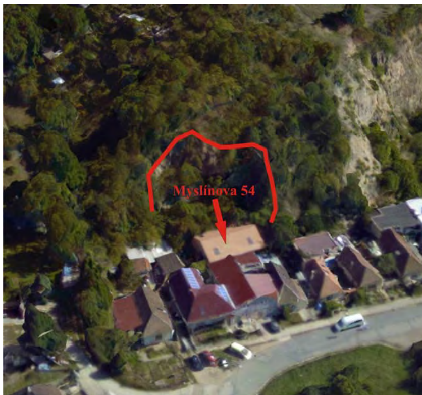
Obr. 14. Letecký pohled na lomovou stěnu za domem v Myslínově ulici č.p. 54. Podle www.seznam.cz/mapy .
