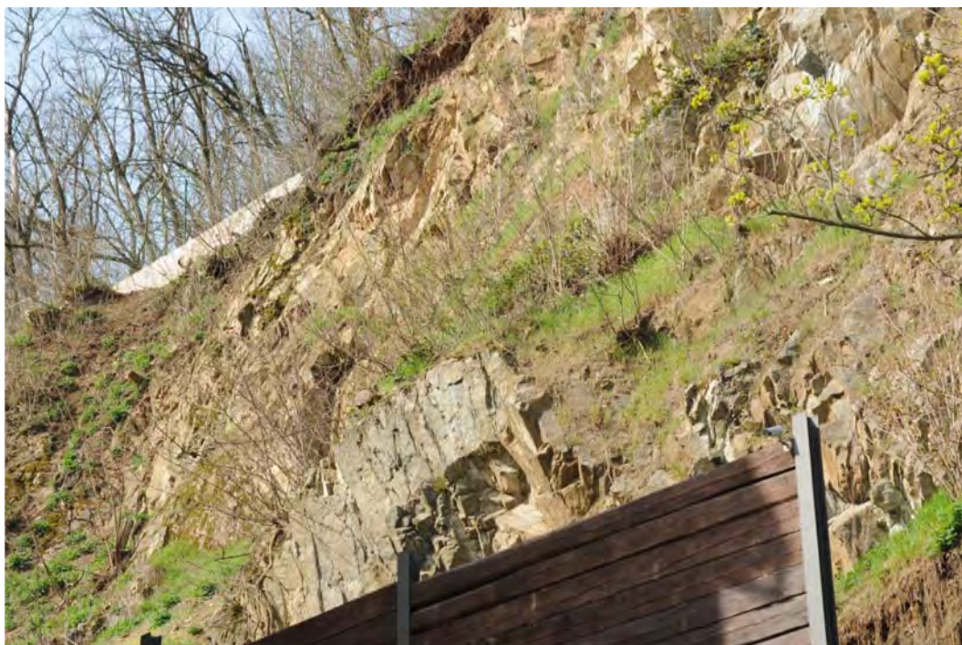
4. Pohled na stěnu s aktivním skalním říčením za obytným domem v ulici Veslařská. Foto O. Krejčí, duben 2015.
