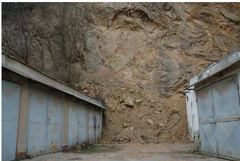
Obr. 13. Pohled na lomovou stěnu za garážemi v Myslínově ulici s čerstvě spadlými kameny. Foto O. Krejčí 2011.
