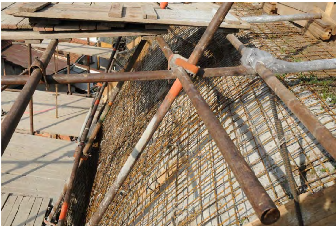
Obr. 2. Výstavba stabilizačních prvků za domem v ulici U Smyčky 6. Foto O. Krejčí, duben 2015.
