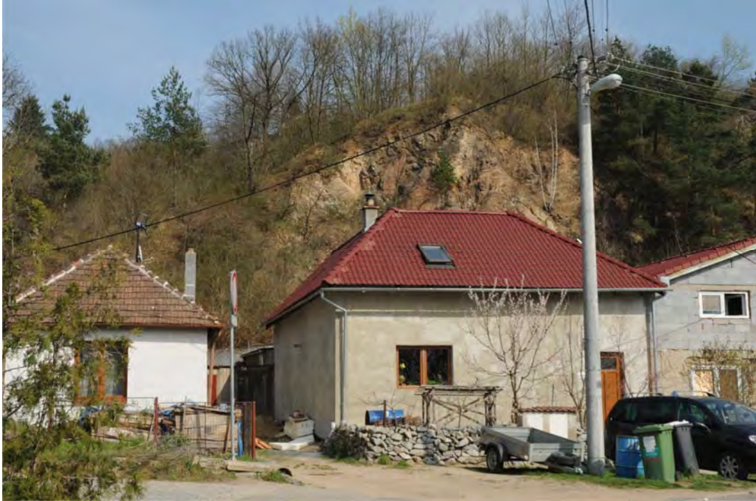
Obr. 3. Celkový pohled na horní část stěny za dome v ulici Myslínova č. p. 54 (dům není vidět, je za domem v popředí snímku). Foto O. Krejčí, duben 2015.
