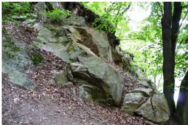
Obr. 6: Vypadnutý ný blok při západním okraji, zastavený o strom (foto A. Havlín, květen 2015).
