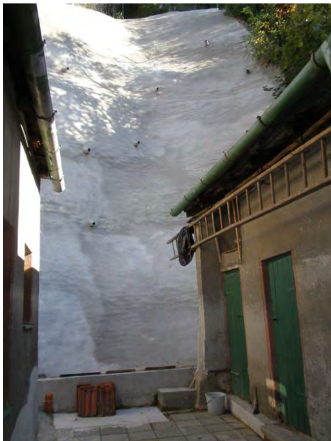
Obr. 3. Ochranná stěna za domem Práčata č. p. 26. Foto O. Krejčí, září 2010.
