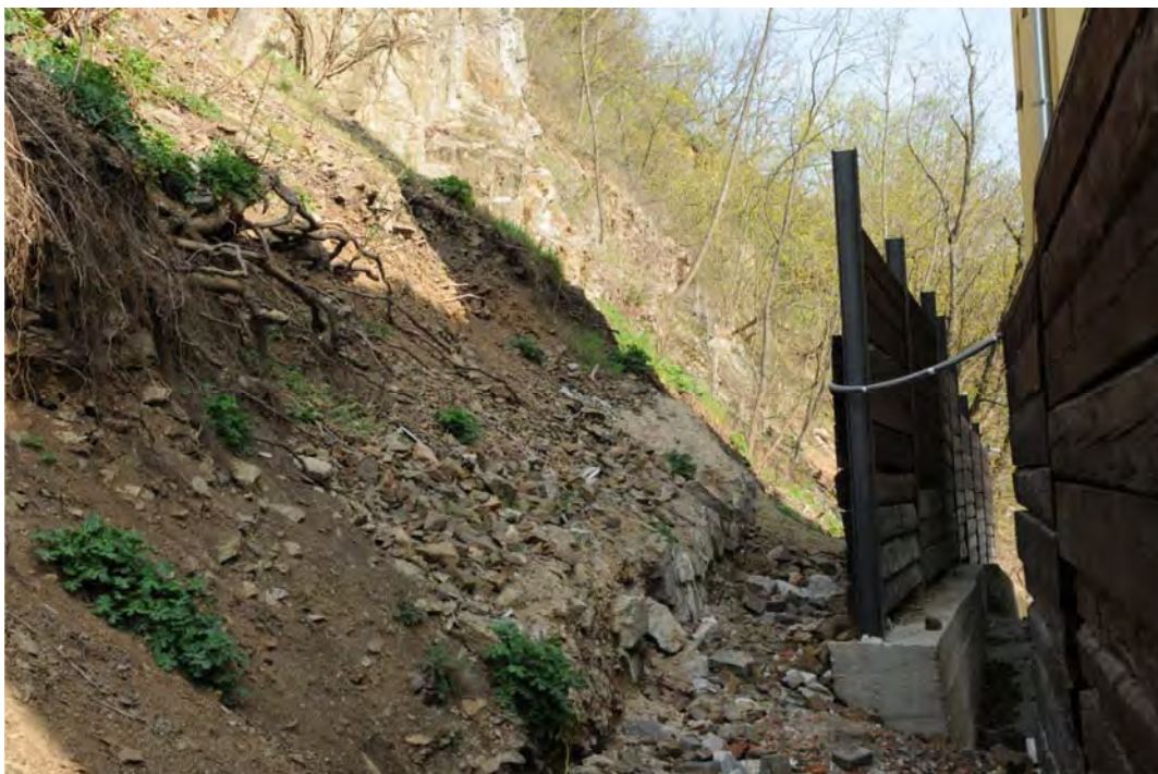
3. Pohled na palisádovou stěnu za obytným domem v ulici Veslařská s čersvě napadanými kameny. Foto O. Krejčí, duben 2015.
