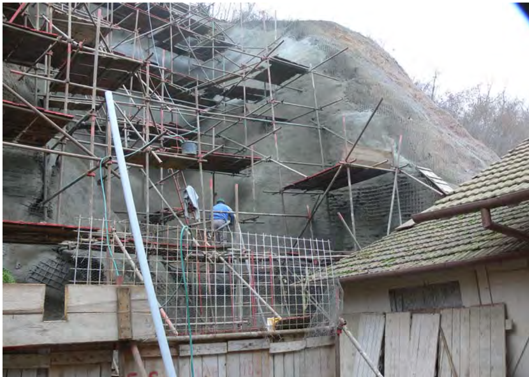
Obr. 2. Celek rozpracované sanace stěn kari sítěmi a stříkaným betonem v Bosonohách. Foto J. Zvelebil prosinec 2006.
