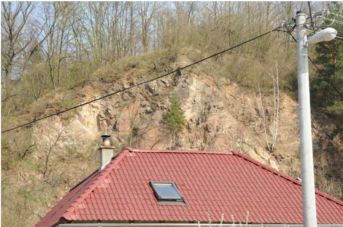
Obr. 4. Bližší pohled na horní část stěny za dome v ulici Myslínova č. p. 54 (dům není vidět, je za domem v popředí snímku). Foto O. Krejčí, duben 2015.
