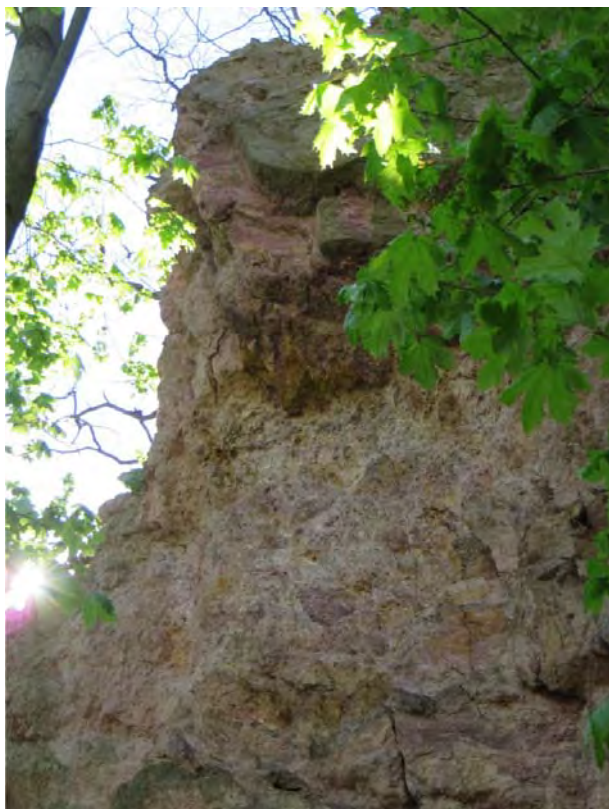
Obr. 1. Skalní převís za rodinným domem na ul. Kamenná čtvrť č. p. 59. Foto H. Gilíková, duben 2015.
