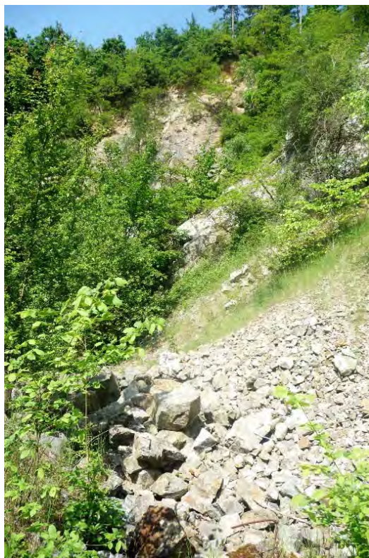
Obr. 8: Střední část severovýchodní stěny lomu – opad horniny (foto A. Havlín, květen 2015).
