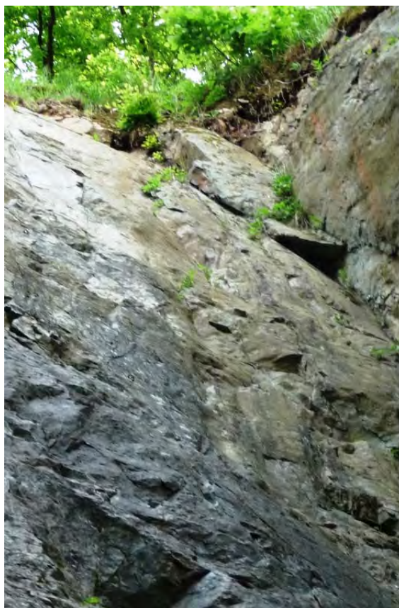
Obr. 6: Rozvolněný blok v horní části při východním okraji (foto A. Havlín, květen 2015).
