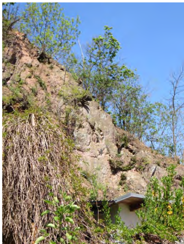
Obr. 2. Lomová stěna za domem č. p. 53. Skalní opady přímo ohrožují rodinný dům. Foto H. Gilíková, duben 2015.
