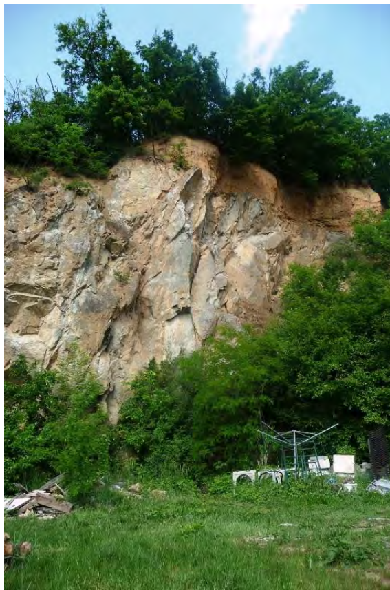
Obr. 30: Severní okraj lomu – prostor pod uvolněným blokem (foto A. Havlín, květen 2015).
