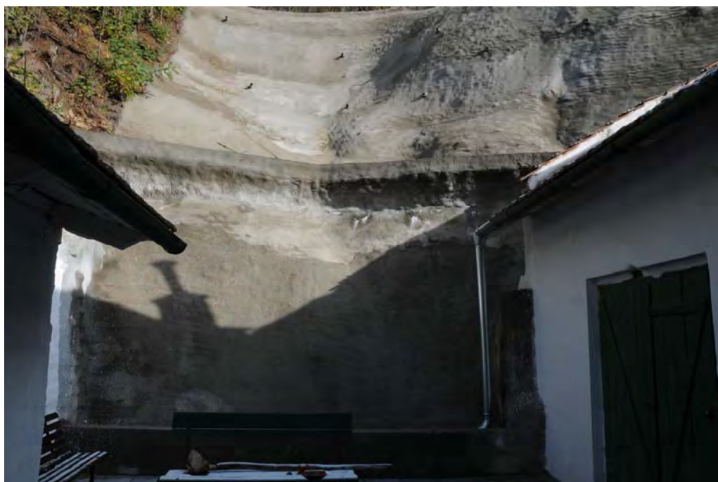
Obr. 3. Pohled na ochrannou stěnu za domem Práčata 28. Foto O. Krejčí, říjen 2012.
