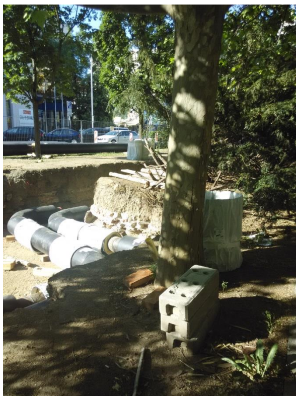
Obr 9 Výkopy u Červeného kostela
