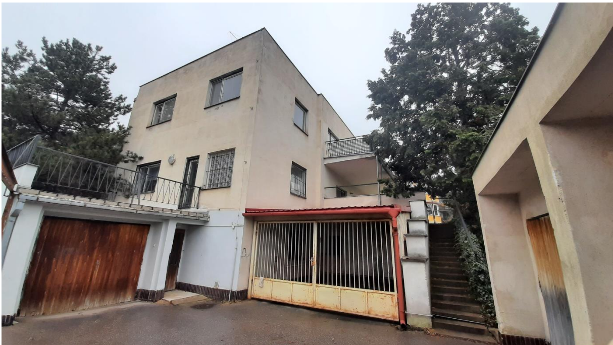
Pohled na budovu z bočního vjezdu
