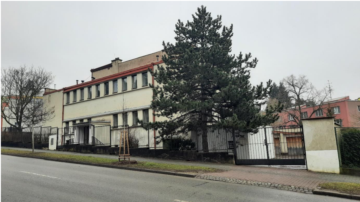
Pohled na budovu Lipová č.or.31 na pozemku p.č. 404 v k.ú. Pisárky
