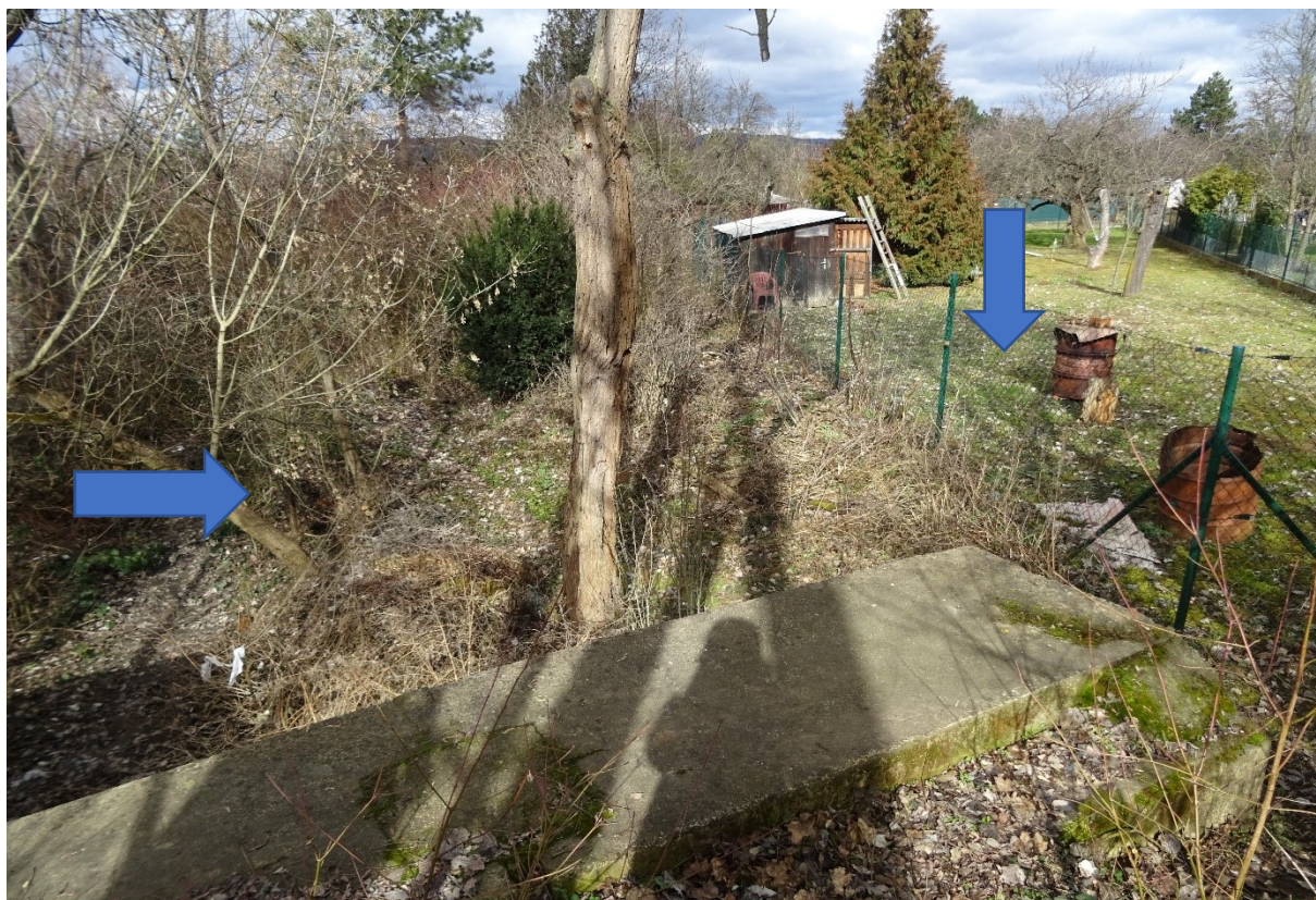
pozemek p.č. 7529/48, k.ú. Židenice
