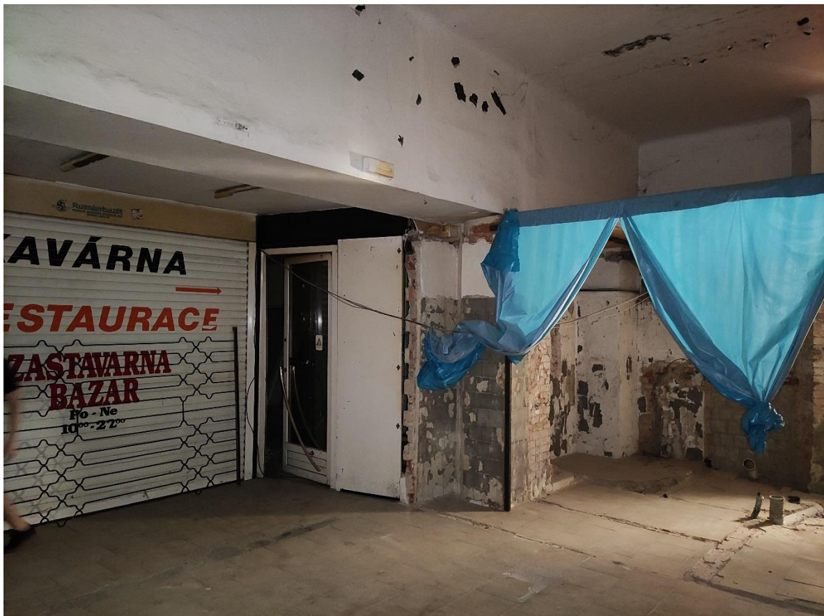
Přístup z prostor domu Josefská 23
