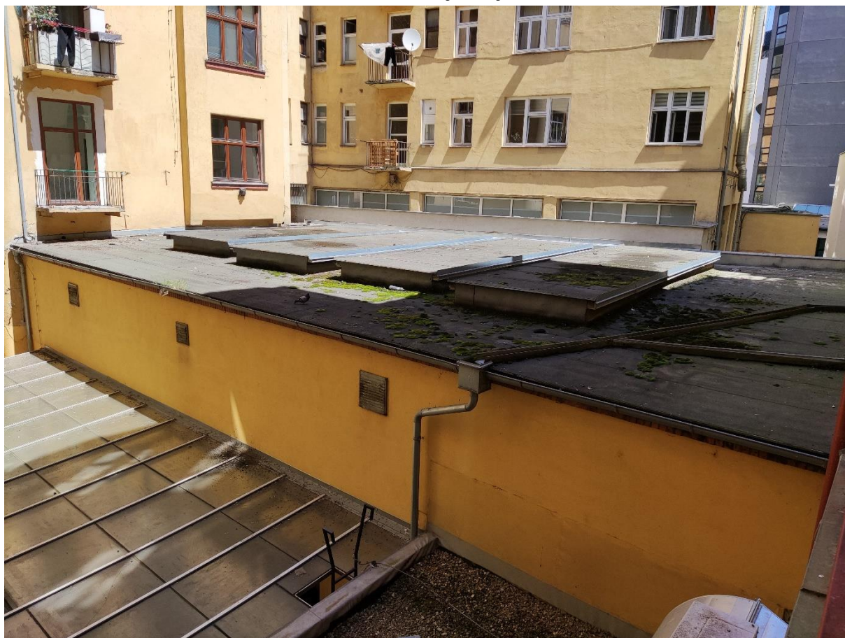
Pohled z vnitrobloku na objekt bývalého kina Čas
