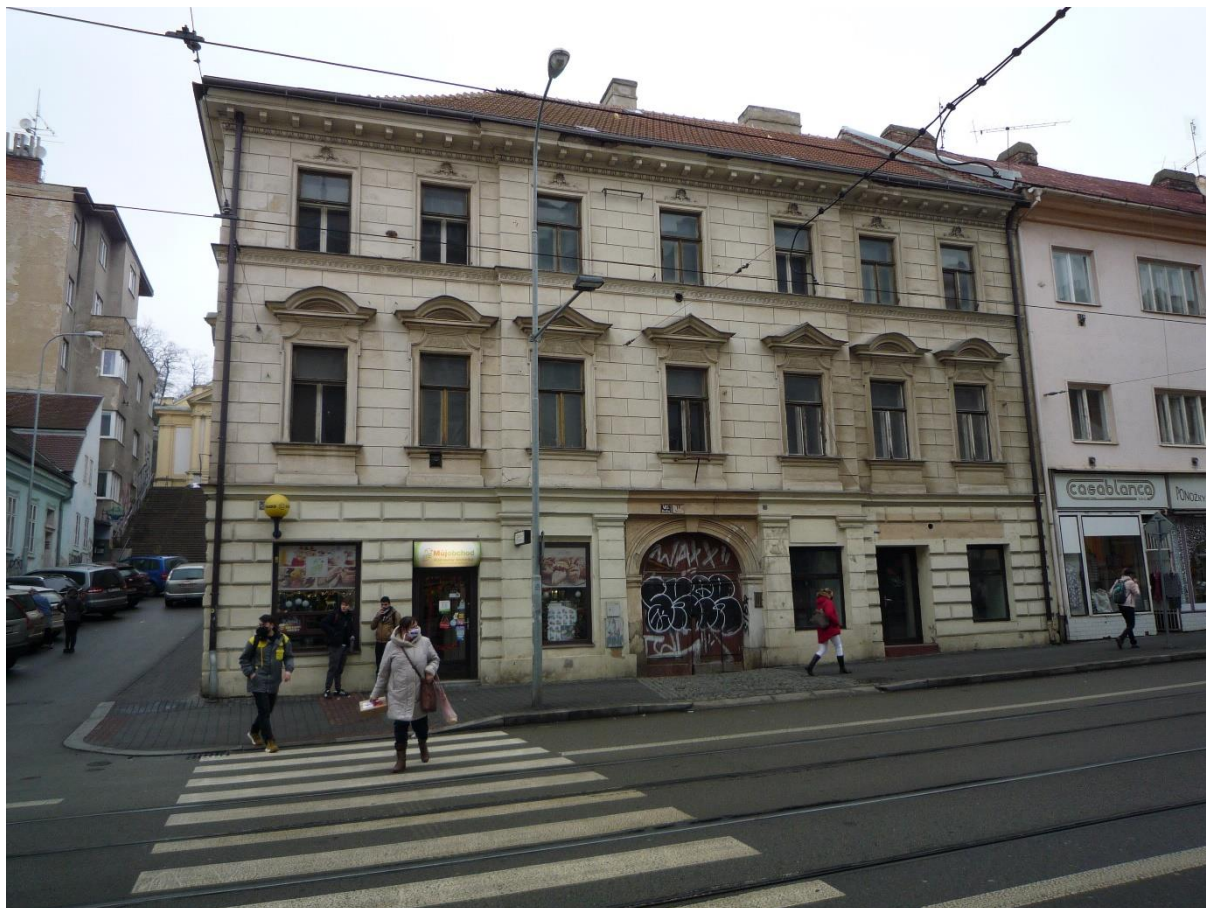
Čelní pohled na objekt Pekařská č. or. 16 na pozemku p. č. 1124 k. ú. Staré Brno
