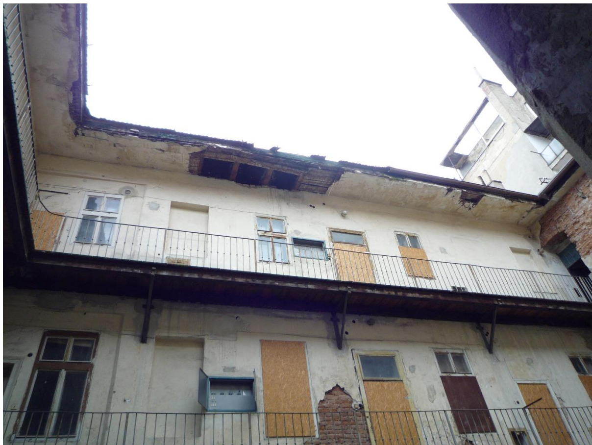
Pohled ze dvora na pavlače
