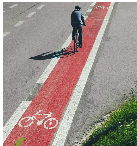
Obrázek 1 – Typická realizace formou změny dopravního značení (ul. Křižíkova)
