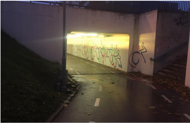
Obrázek 60 – Podjezd pod ulicí Heršpická (zdroj: Analýza bezpečnosti podjezdu Heršpická, KAM/2020)
