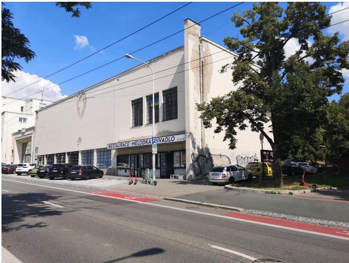
jihozápadní nároží – na jižní fasádě bude umístěn výtah
