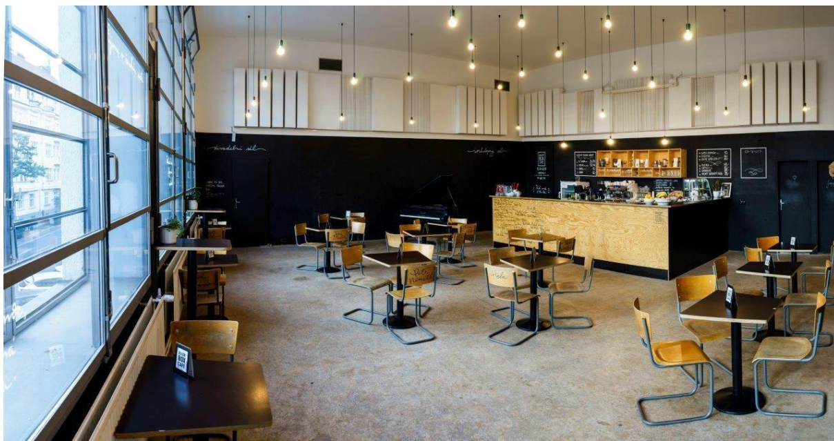
interiér Black Box Café s repasí původních oken a vyspravenou původní xylolithovou podlahou – foto D. Husárová
