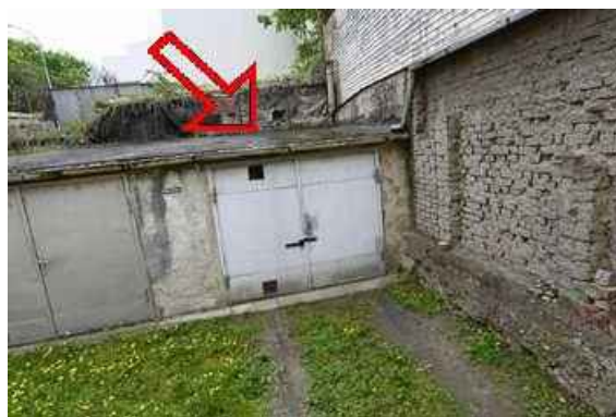
garáž č.e. 419 na p.č. 419/3
