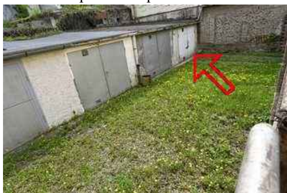
garáž č.e. 419 na p.č. 419/3
