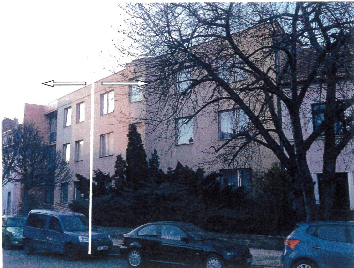
Foto č. 1: uliční pohled na posuzovaný objekt, který za účelem posudku byl rozdělen na objekt „A“ a objekt „B“
