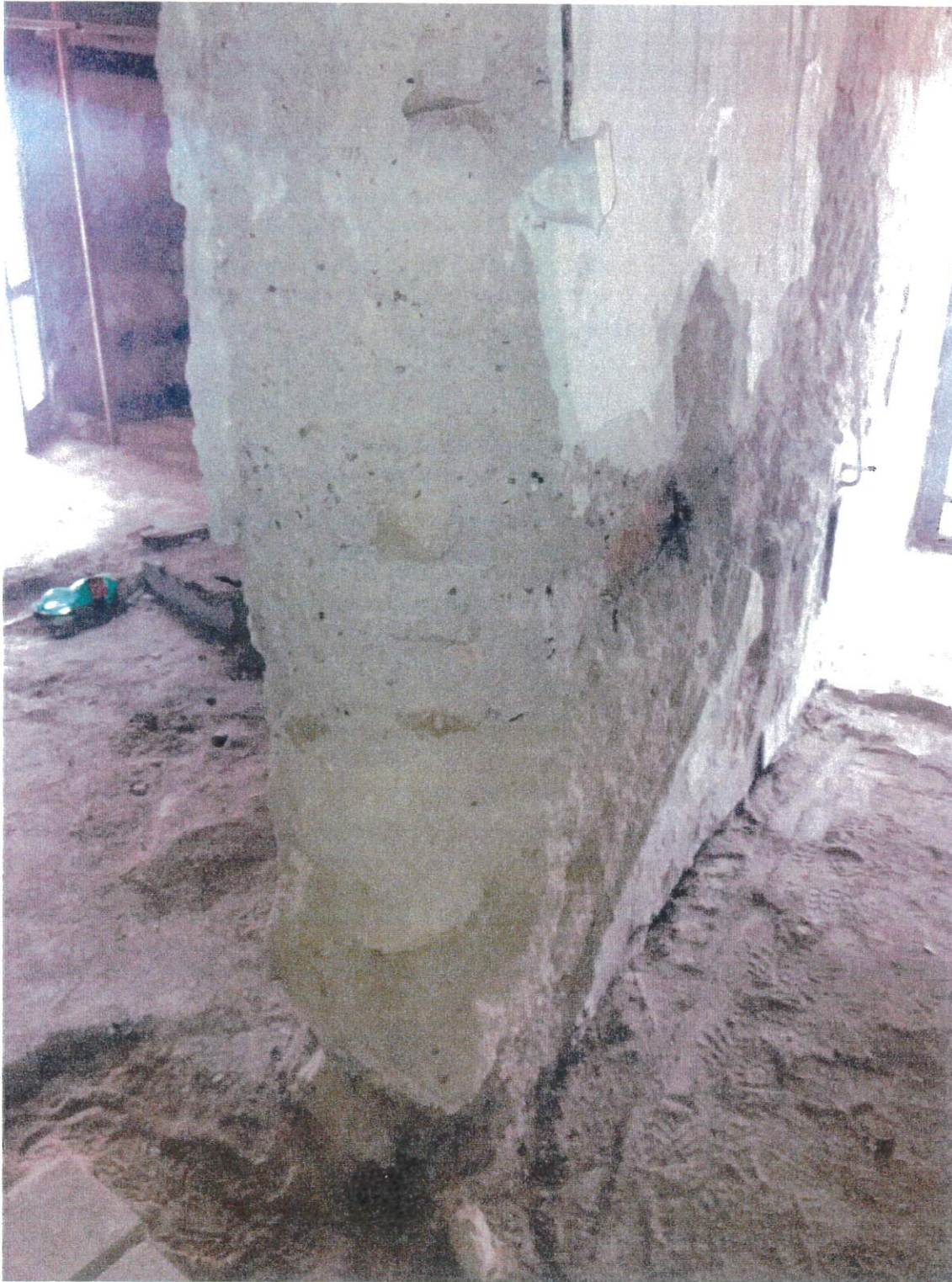
Foto č. 6: Detailní pohled na nosné vnitřní zdivo mezi místnostmi číslo 109, 110 a 118
