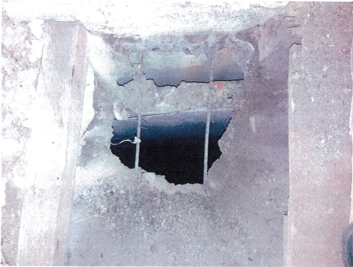
Foto č. 8: Detailní pohled na sondu v stropní konstrukci v místnosti číslo 211
