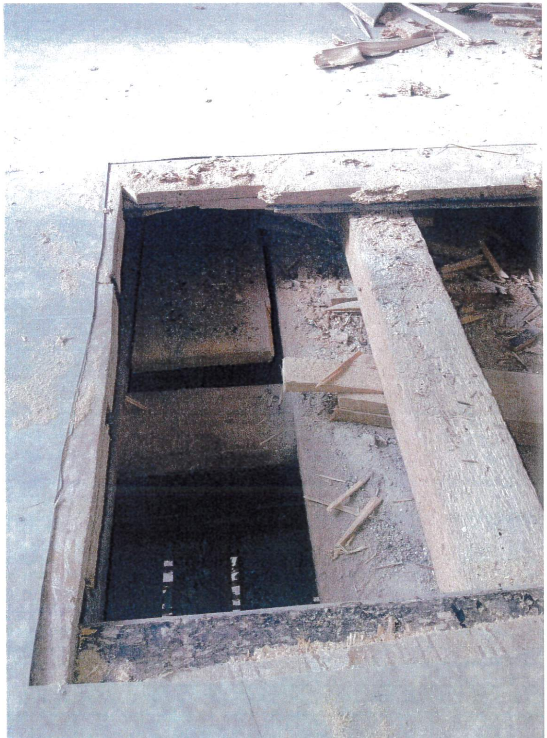
Foto č. 9: Detailní pohled na sondu v stropní konstrukci v místnosti číslo 310
