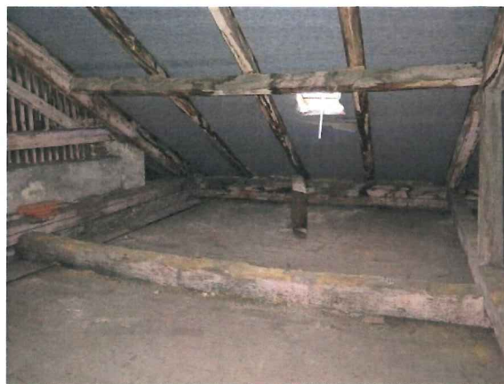
Obr. 6 - Trám vynášející stropní trámy nad 3.NP zadního objektu na ulici Vodní
