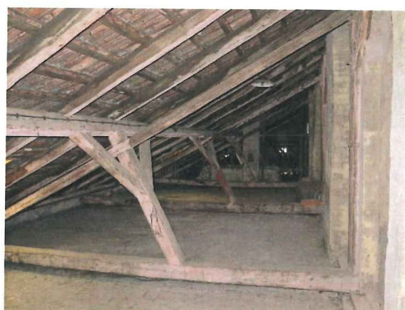
Obr. 4 - Pohled do prostoru krovu druhé části pultové střechy nad dvorním traktem
