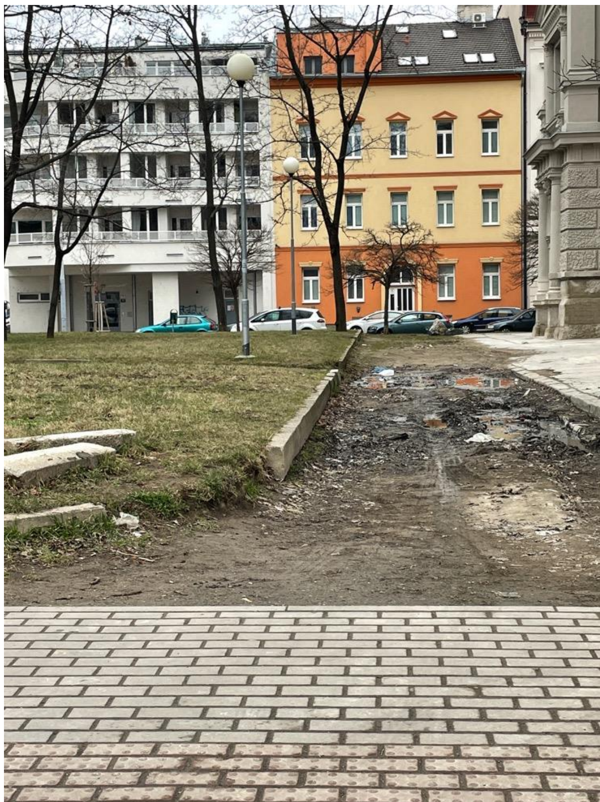
Pohled na předmětnou část pozemku p.č. 2/4 v k.ú. Trnitá na Šujanově náměstí
