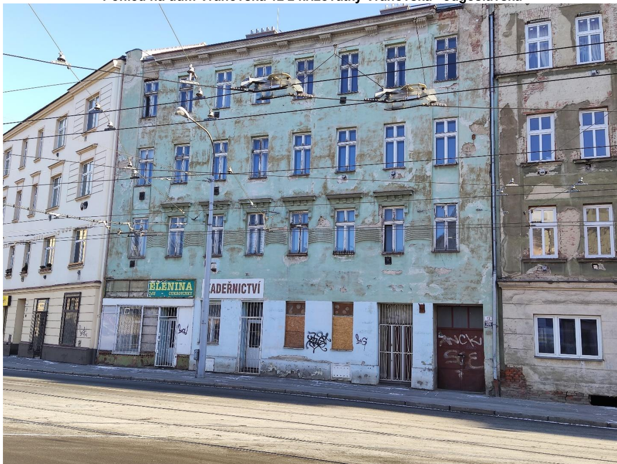
Pohled na dům Vranovská 12 z křižovatky Vranovská - Jugoslávská
