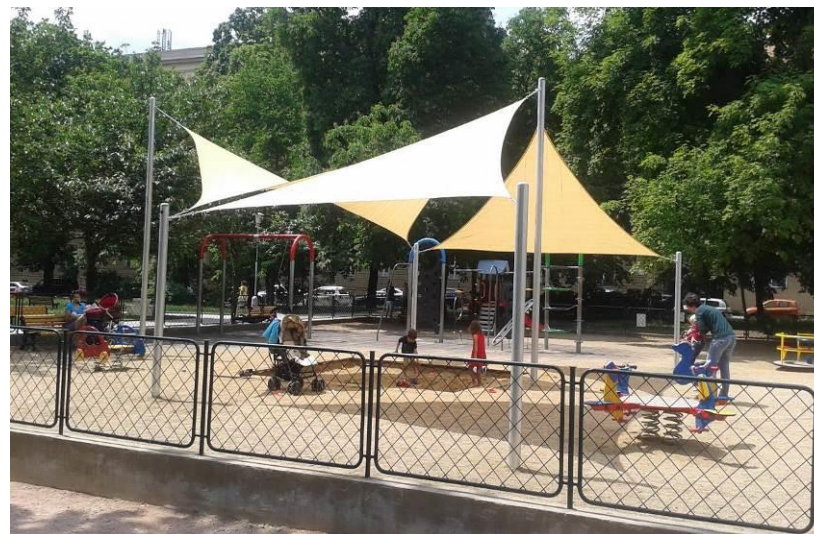
Brno, Obilní trh – dětské hřiště kryté fixním stíněním
