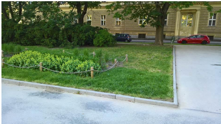
Trávník se záhonky olemovaný zbytečně vysokými obrubníky
