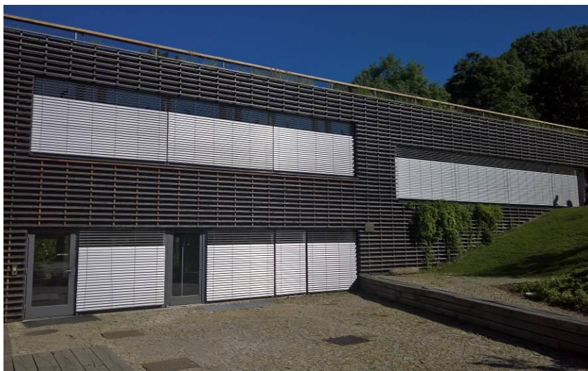
Brno – důkladné vnější stínění pasivní budovy v areálu Otevřená zahrada Nadace Partnerství
