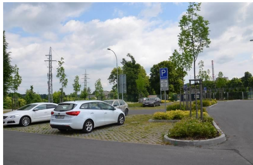
Pízeň, Štruncovy sady – parkoviště s polopropustnou plochou
