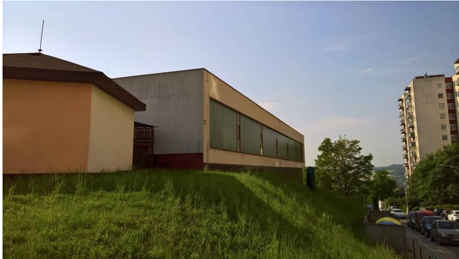
Současný stav – opuštěná výměňiková stanice v těsném sousedství sídliště
