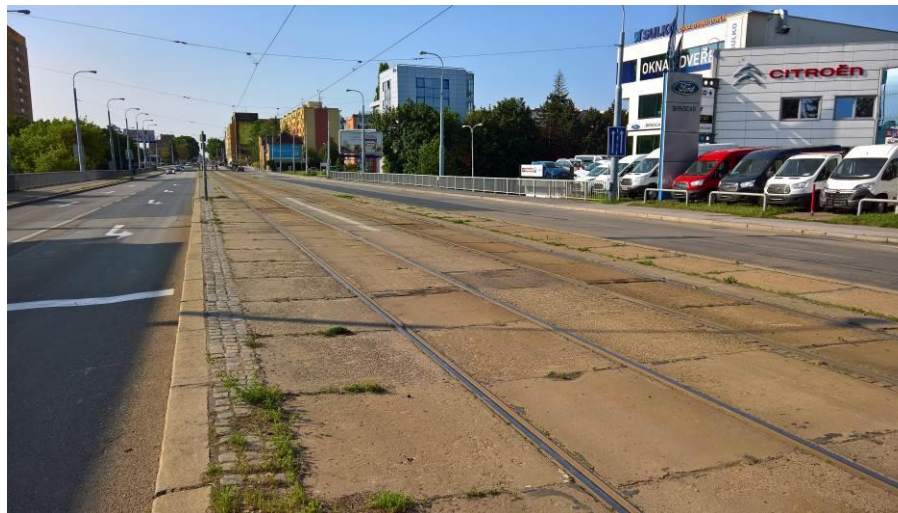
Brno, Královo pole, Palackého třída – lokalita vhodná k provedení opatření
