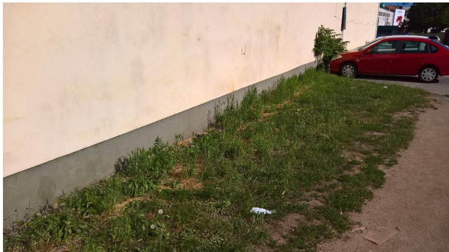
Současný stav – okapový chodník
