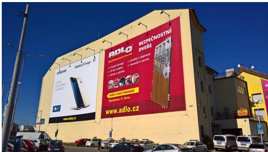
Současný stav – západní expozice fasády domu Křenova 288/4
