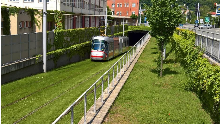
Brno, Pisárky – intenzivní tramvajový pás
