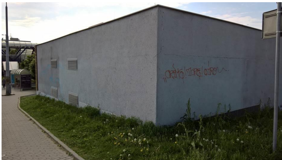
Brno, Nový Lískovec Oblá 504/12b - výměňková stanice
