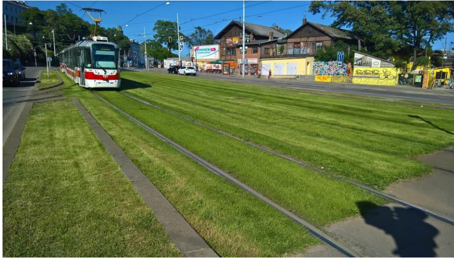
Brno, Nové sady – intenzivní tramvajový pás
