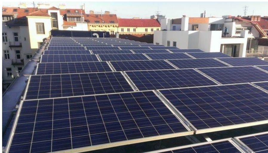
Brno - Fotovoltaická elektrárna na střeše využívaná pro místní spotřebu – Otevřená zahrada, Údolní 33
