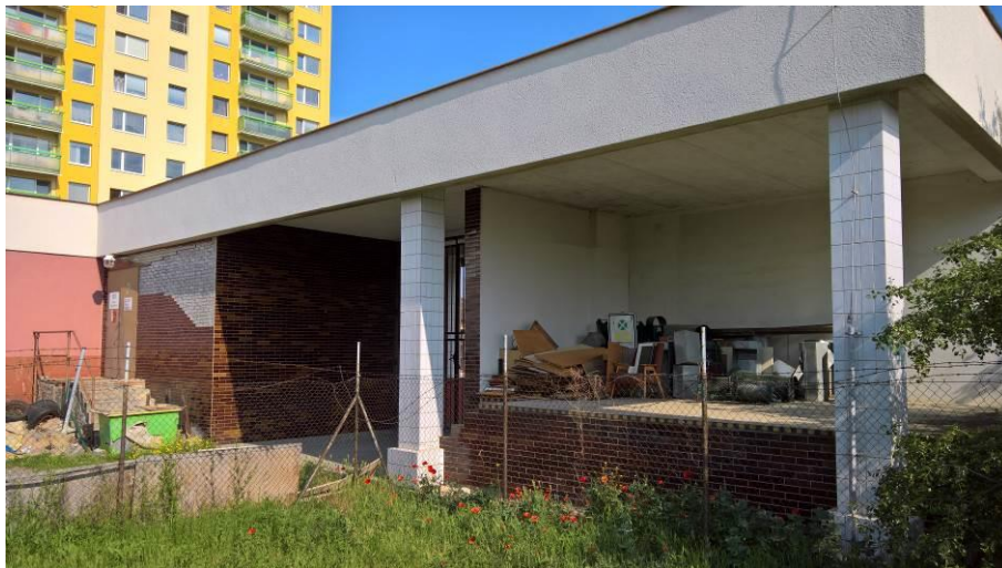
Současný stav – „brownfield“ výměňiková stanice
