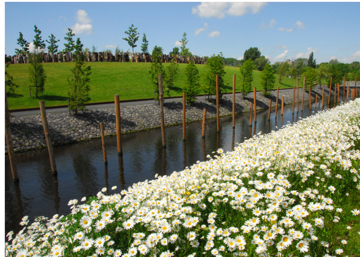
vegetační úprava svahu při vodním toku
