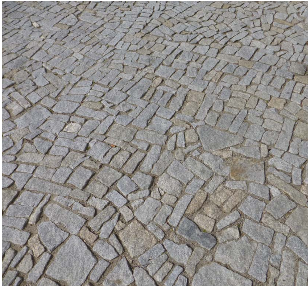
kamenná dlažby - žulové odseky
