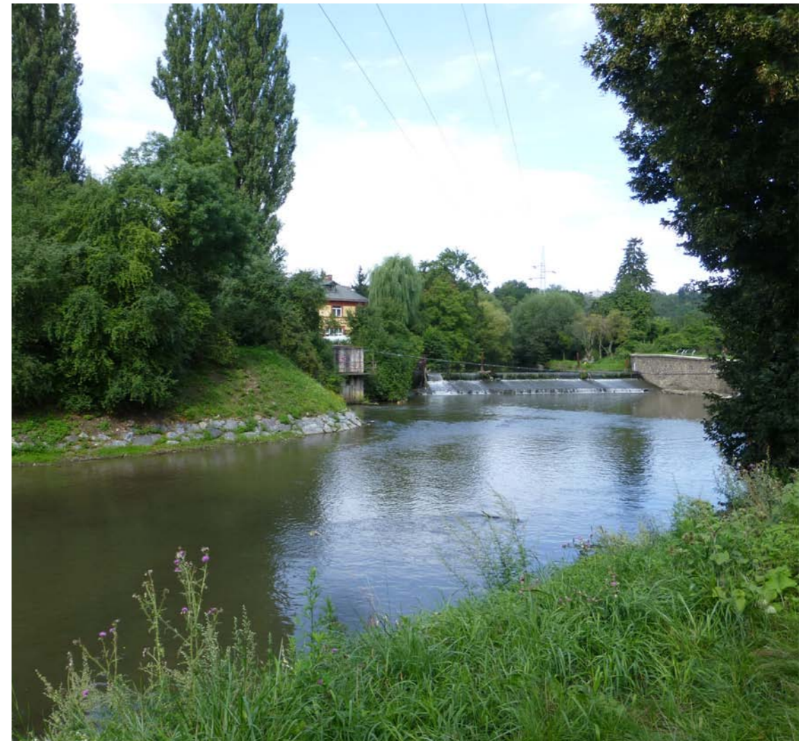
pohled z protilehlého břehu řeky Svitavy
