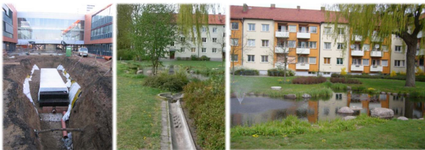
Obrázek 20: Zleva doprava: udržitelné odvodňovací systémy ve výstavbě – kampus MU v Brně, po dokončení v Malmö a Augusteborgu (Švédsko) Zdroj: GRaBS, www.jvprojektvh.cz
