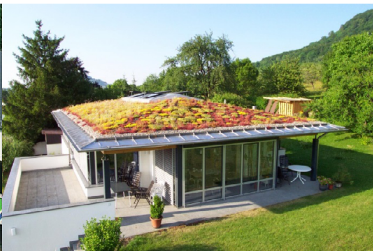
Příklad extenzivní střechy. Foto: Dostálová (2008)
