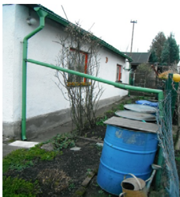
Zásobníky vody - nadzemní plechové. Foto: Jiří Moravec (2016)
