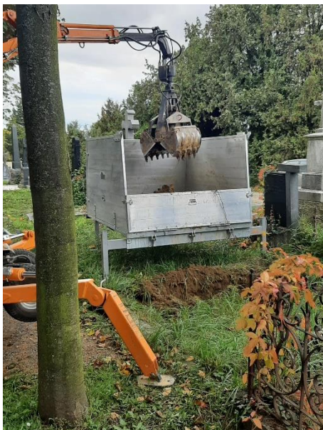
Boxy na vykopanou zeminu
