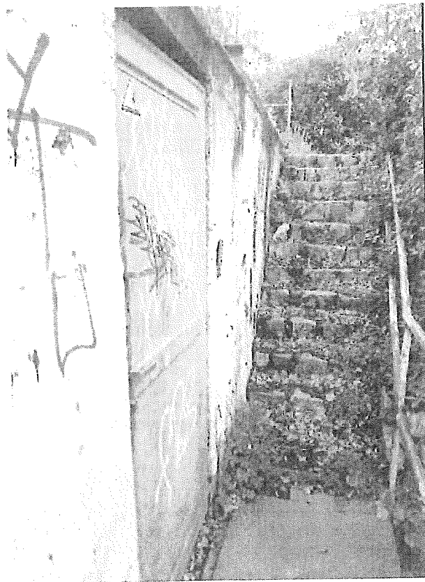
Schodiště při vstupu do budovy MVE
