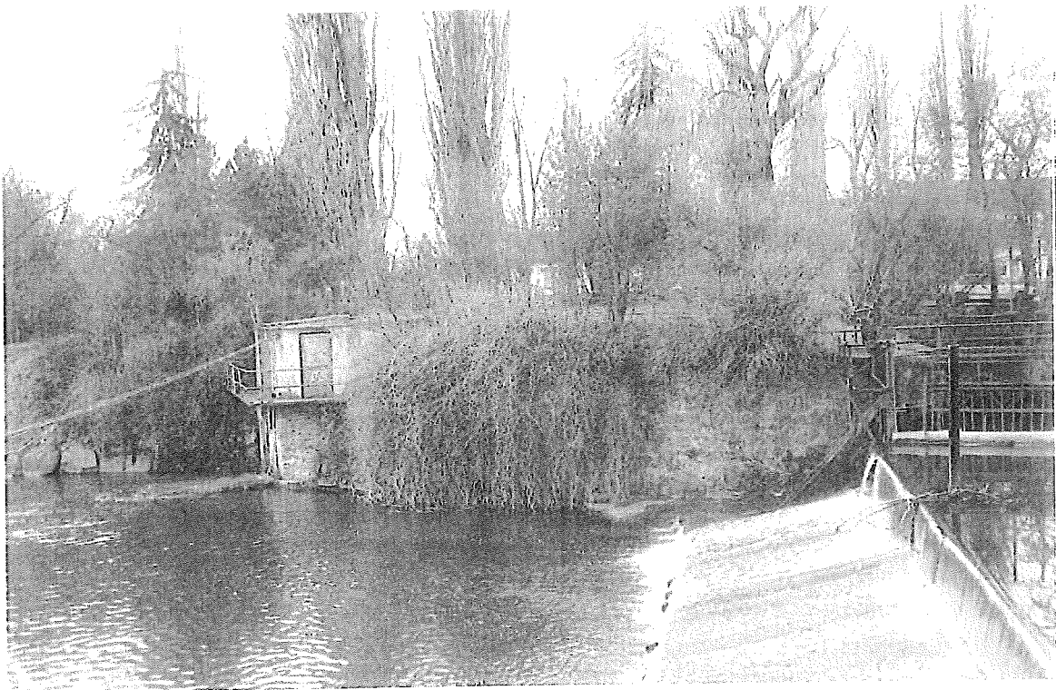
Pohled na budovu MVE
