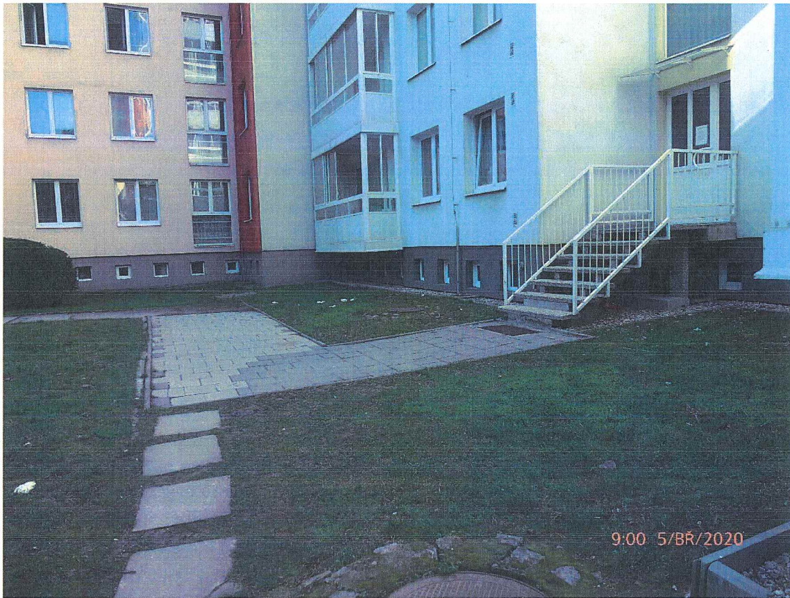
Pohled na část pozemku p.č. 3073 v k.ú. Bohunice, na které je vybudován přístupový chodník k zadnímu vstupu do domu Spodní č. or. 16
