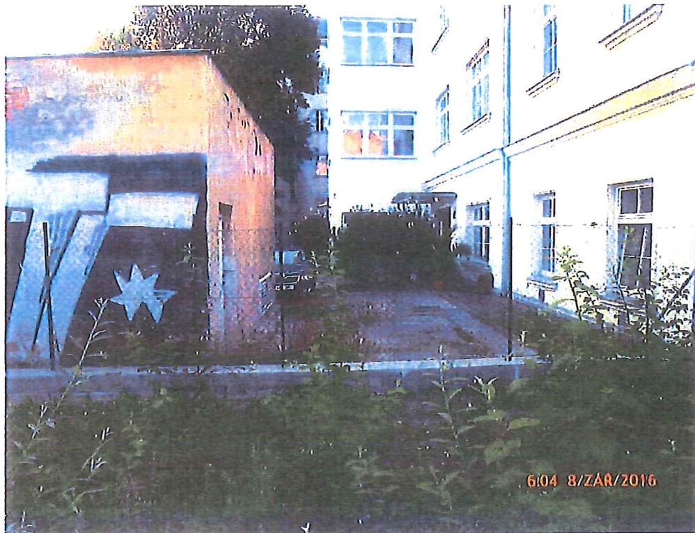
Pohled na řešenou část pozemku p.č. 556/11 v k.ú. Zábřovice
