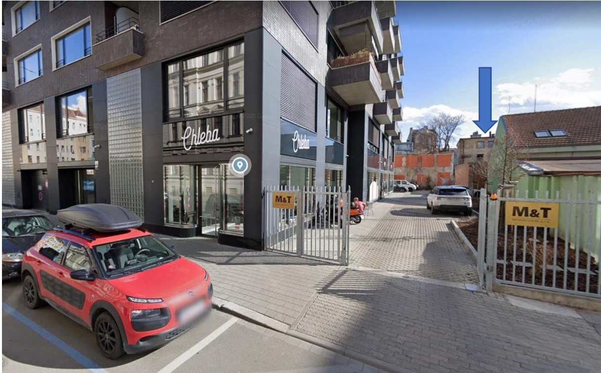
Pohled do vnitrobloku z ulice Bratislavská, přístupová cesta poz. p.č. 716, k.ú. Zábrdovice ve vlastnictví města
