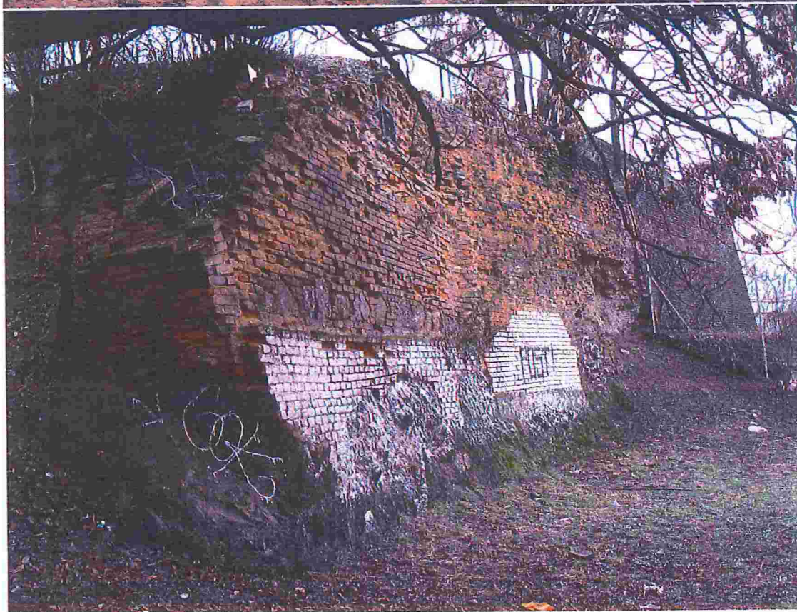
Obr.č.7 – detail vzrostlých dřevin na hřebenu západního křídla Obr.č.8 – pohled na torzní ukončení levé strany západního křídla
