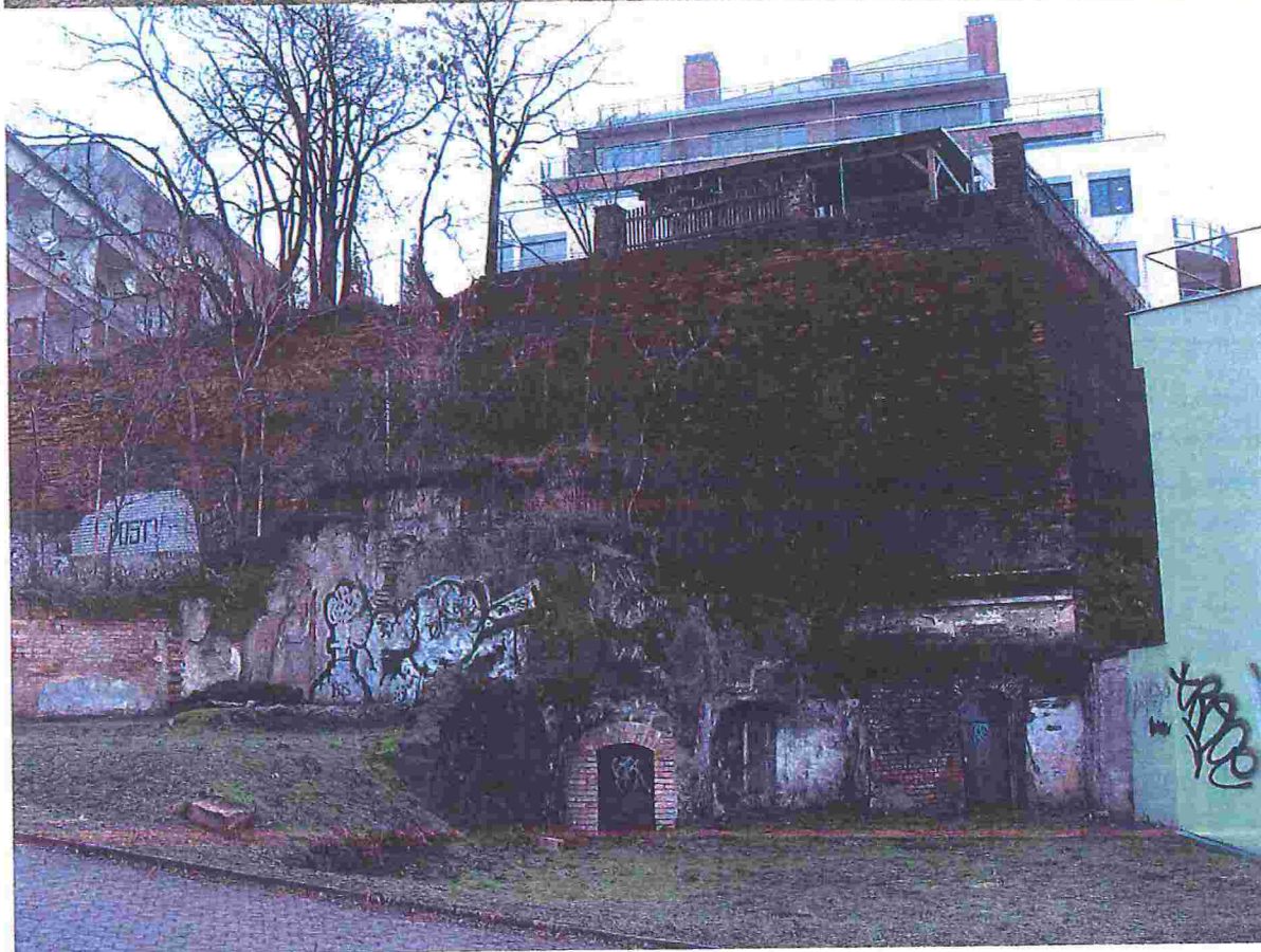
Obr.č.1 a 2 – celkové pohledy na západní křídlo objektu
