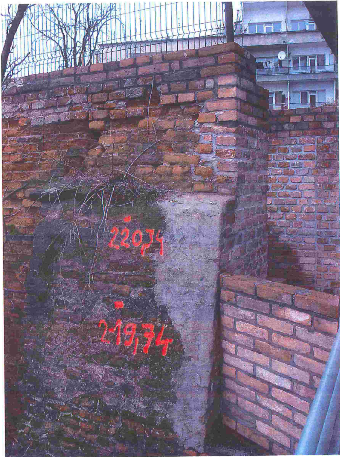
Obr.č.11 – detail pravého konce jižního křídla / navázání schodů a zídky pro vstup na terasu přilehlé kavárny
