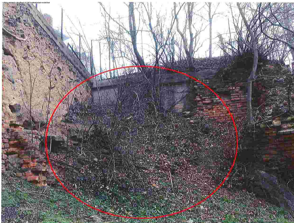
Pohled na předmětnou část pozemku p.č. 1109, k.ú. Staré Brno od ulice Pekařská
