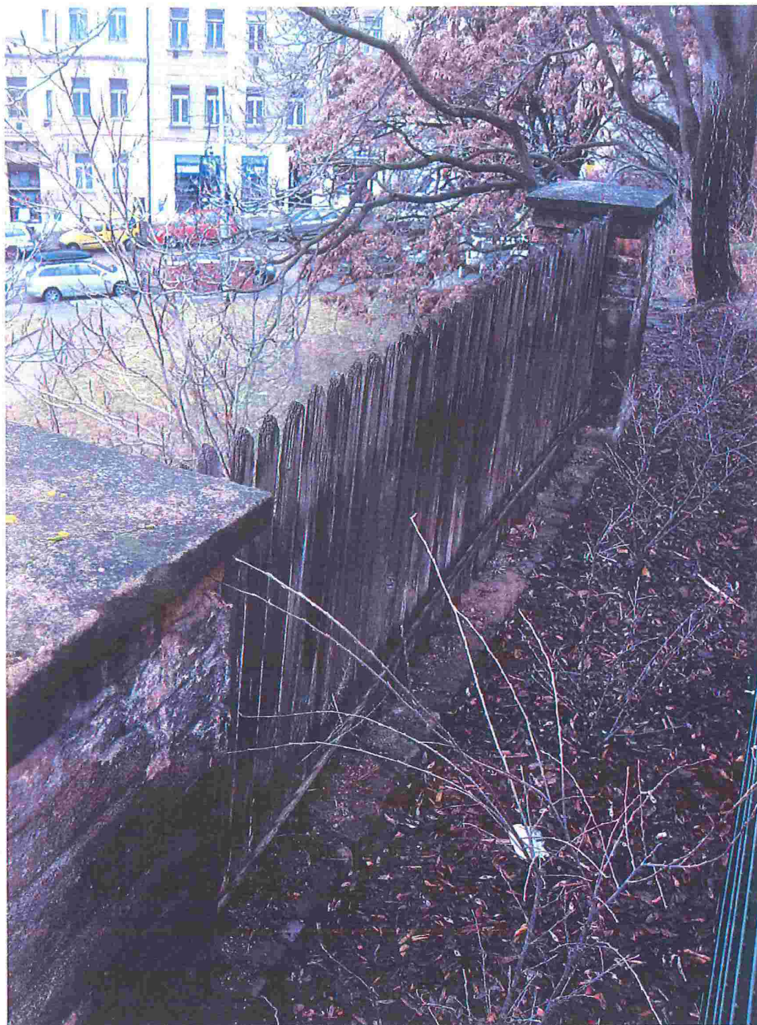
Obr.č.13 – dochovaný díl dřevěného plotu mezi dvěma sloupky s pískovcovou hlavicí, západní křídlo
