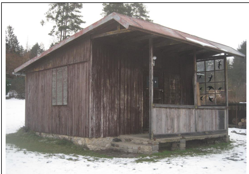
Rekreační chata č.e. 2089 na pozemku parc.č. 5468 k.ú. Bystřec
