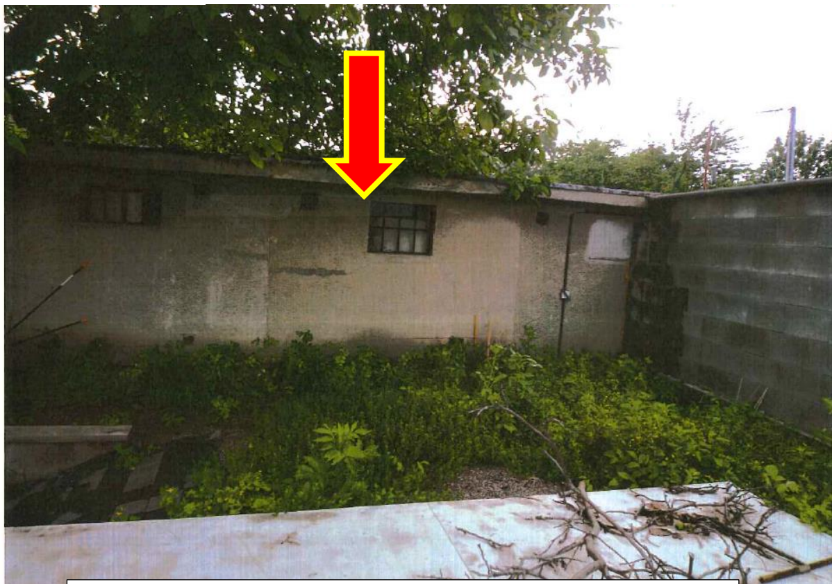
pozemek p.č. 2092/5, garáže a zeď rozdělující pozemek na dvě části
