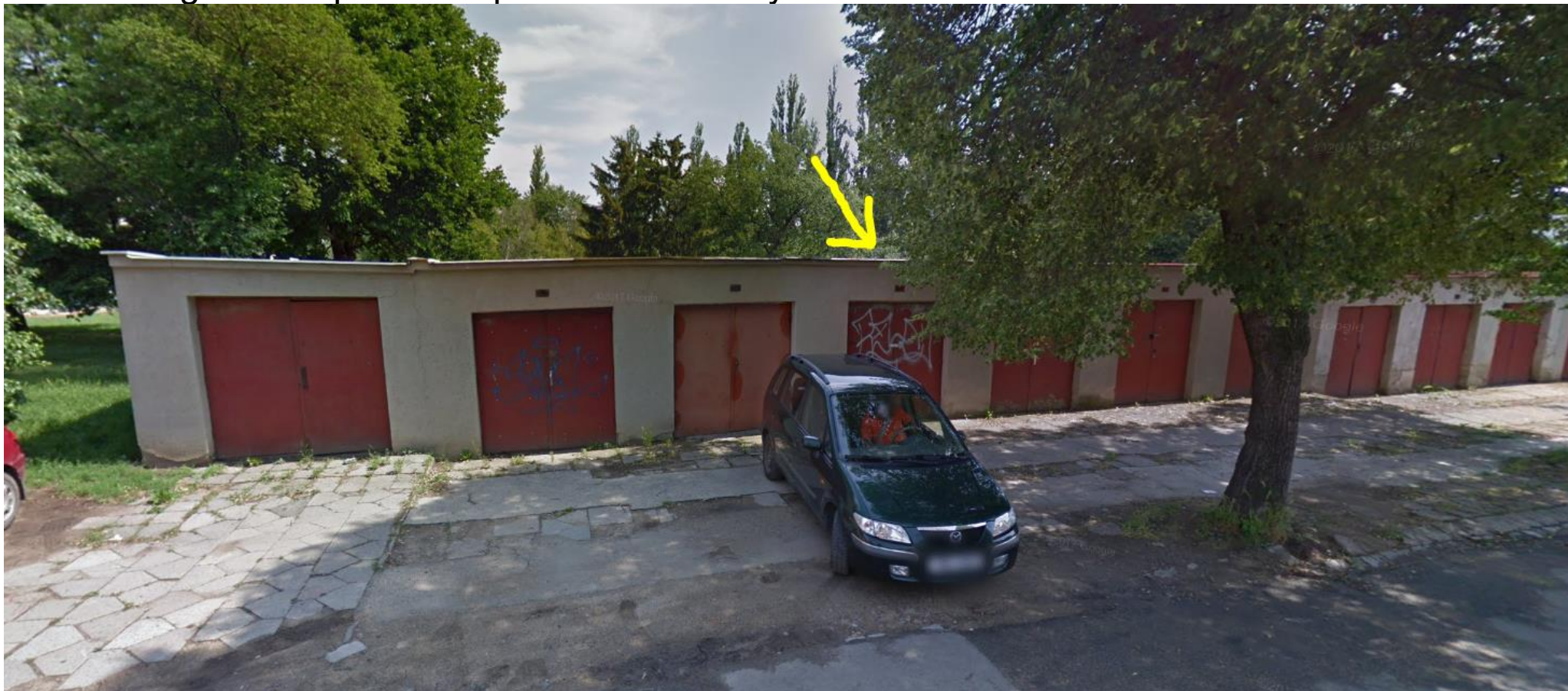
Pohled na garáž na pozemku p.č. 313 v k.ú. Štýřice
