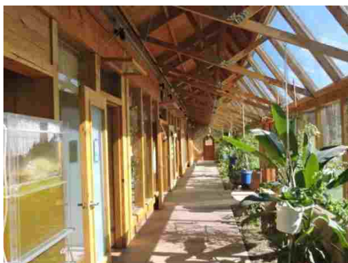
Přirozené stínění jižní fasády předsazenou konstrukcí skleníku.
