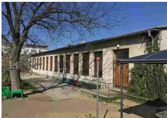
Současný stav jižní fasády MŠ Štolcova bez venkovního stínění
