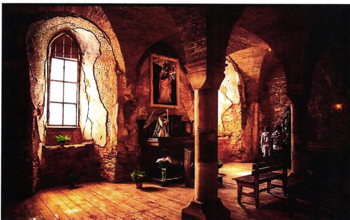
Hrad Hartenberg – kaple po obnově kleneb:
