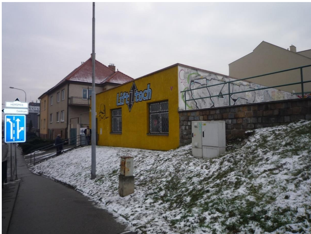
Pohled na stavbu č.p. 114 z ulice Bohunická (ve spoluvlastnictví navrhovatele)
