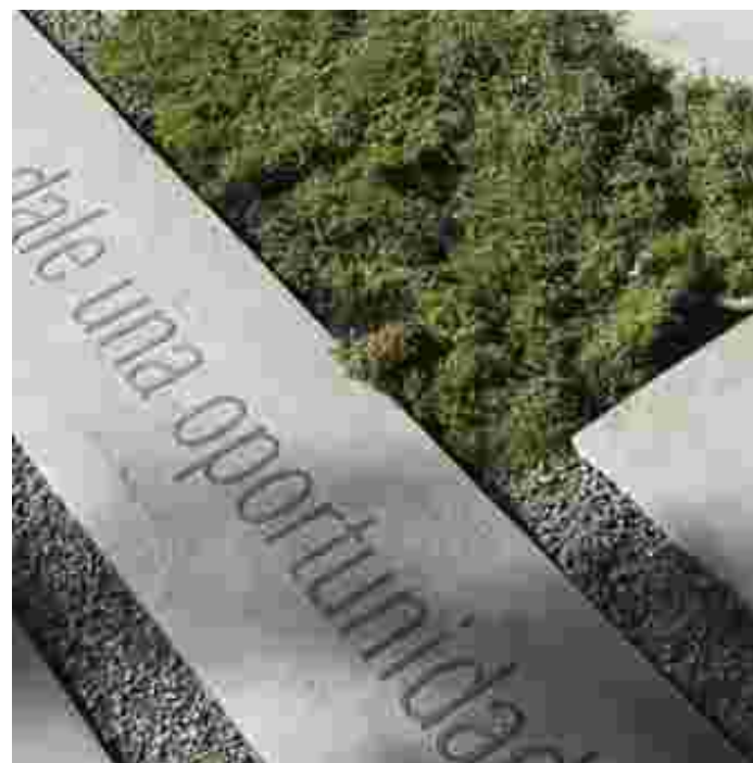
velkoformátová betonová dlažba v kombinaci se suchomilnou vegetací
