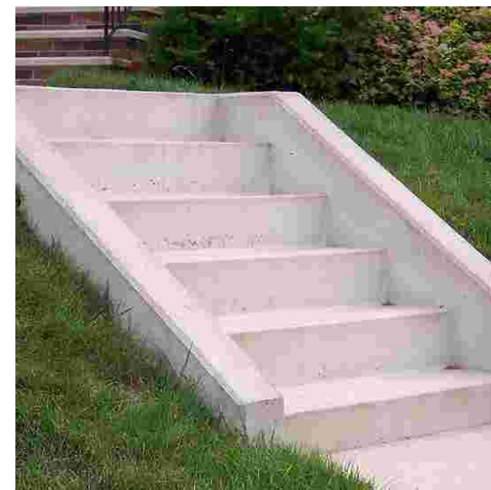
betonové schodiště s bočními opěrami terénu
