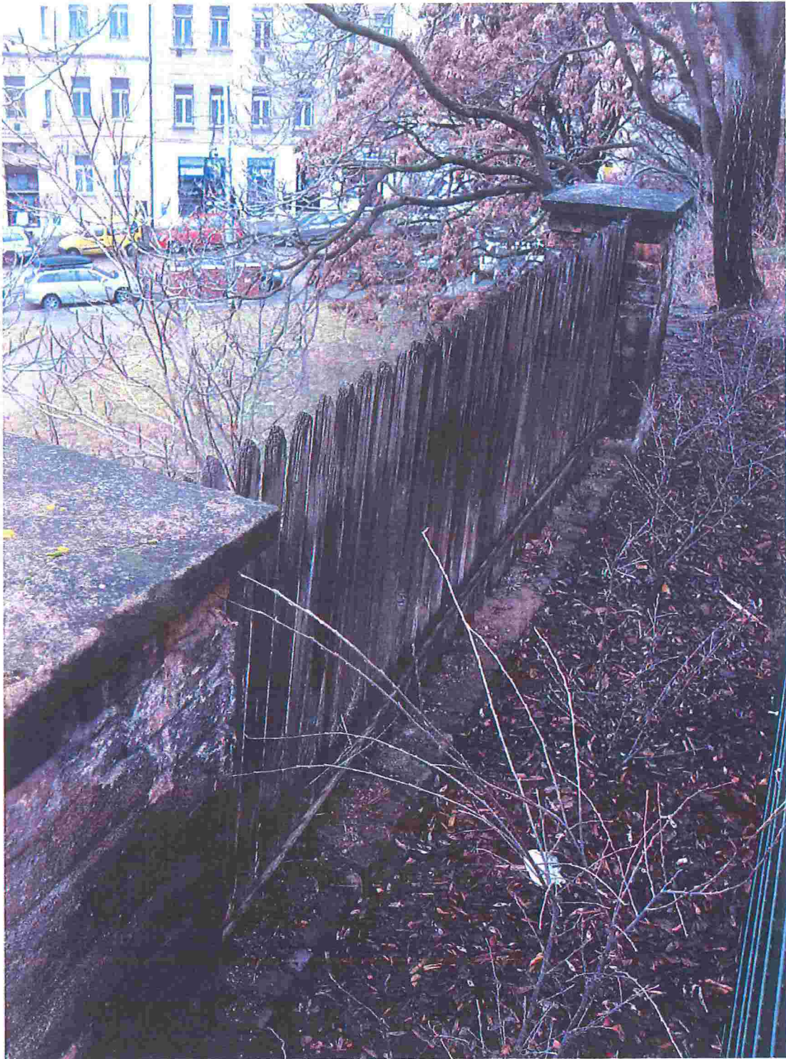
Obr.č.13 – dochovaný díl dřevěného plotu mezi dvěma sloupky s pískovcovou hlavicí, západní křídlo
