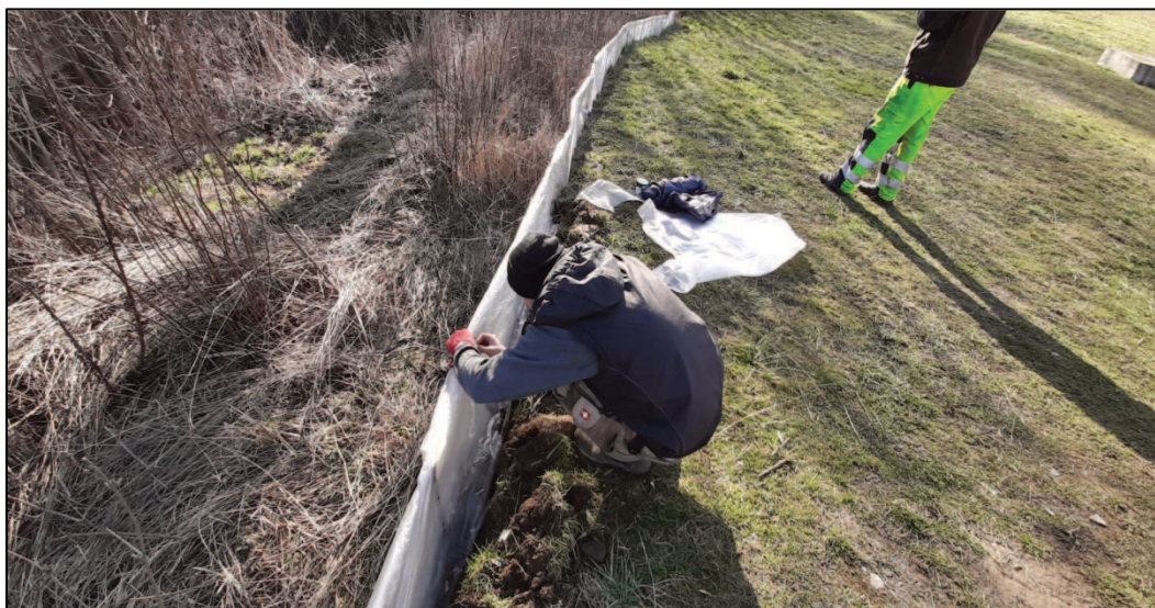
Obr. 9: Oprava poničené části zábrany (foto: Vilém Jurek).
