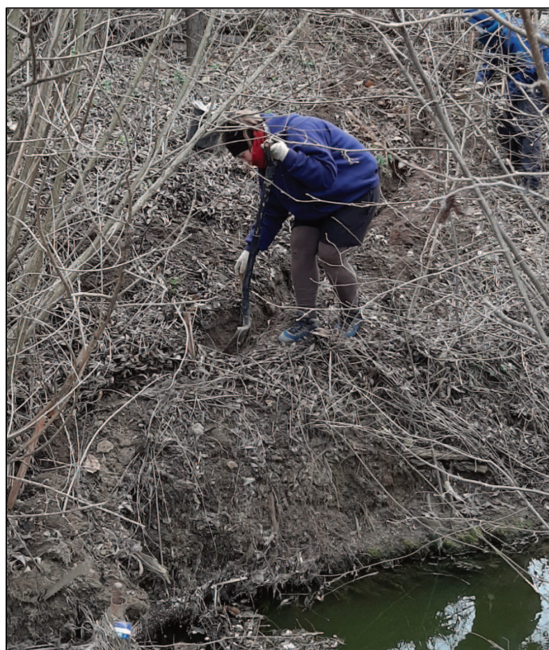
Obr. 8: Příprava rýhy na přihnutí spodní části igelitové zábrany (foto: Vilém Jurek).
