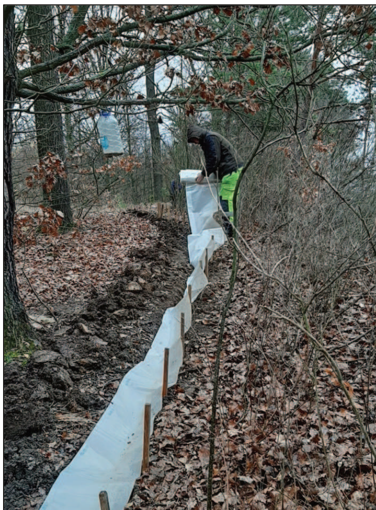
Obr. 10: Instalace zábrany v úseku U Křivé borovice (foto: Vilém Jurek).
