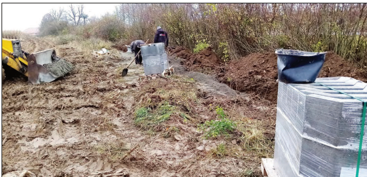
Obr. 26: Budování poslední etapy pevných zábran – Větev „D“, listopad 2020 (foto Josef Ferenc).
