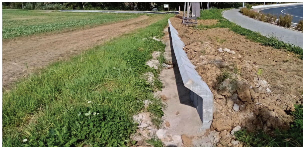
Obr. 24: Budování poslední etapy pevných zábran – Větev „E“, říjen 2020 (foto Josef Ferenc).
