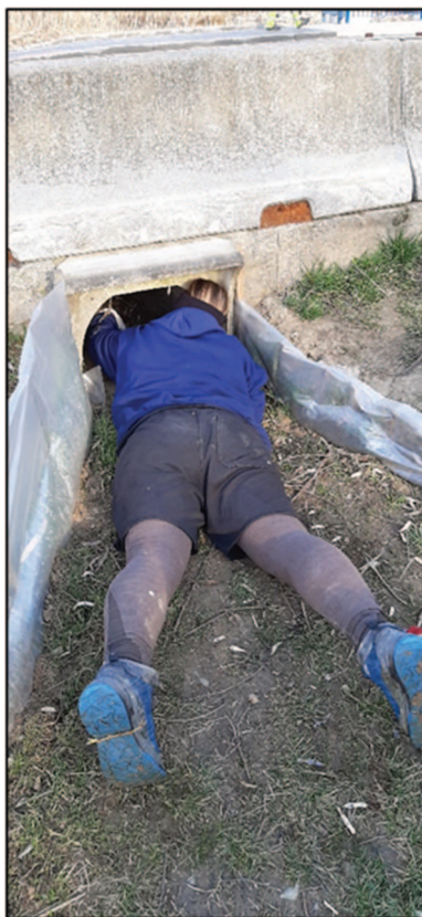
Obr. 5: Čištění jednoho z průchodů (foto Antonín Nový).
