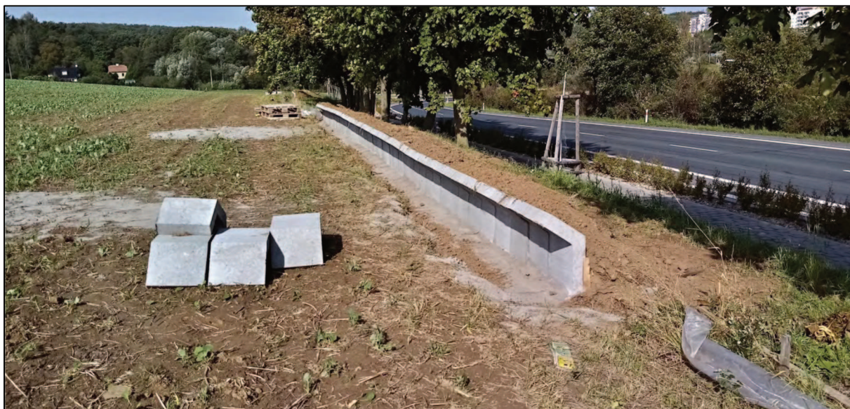
Obr. 25: Budování poslední etapy pevných zábran – Větev „E“ – říjen 2020 (foto Josef Ferenc).
