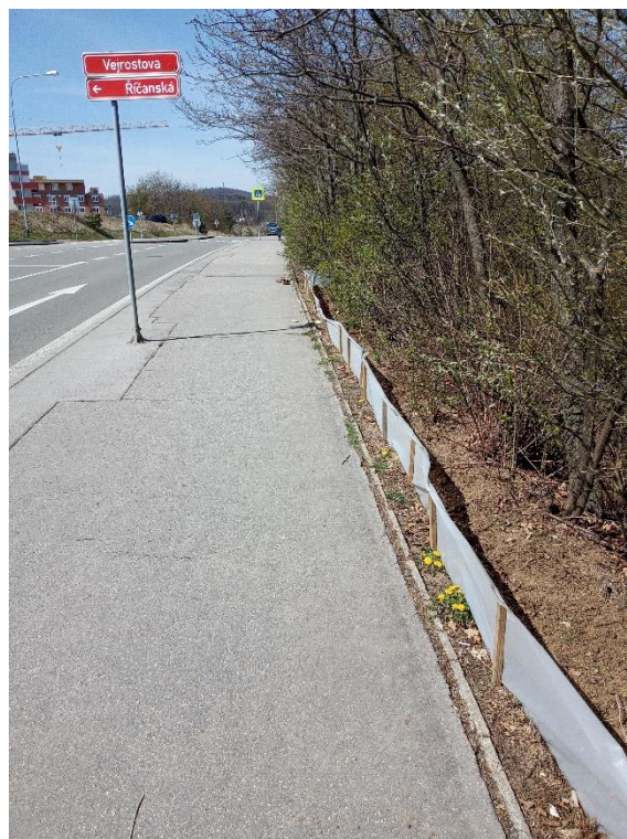
Vybudovaný úsek „sídlíště“.
