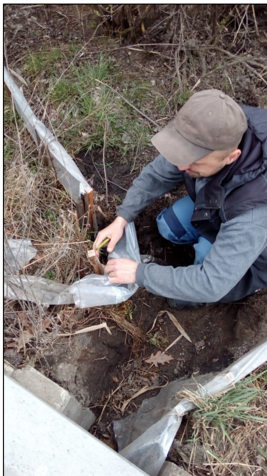
Obr. 9: Pracovník Rezekvítku opravuje poškozenou část migrační bariéry (zdroj: Rezekvítek)
