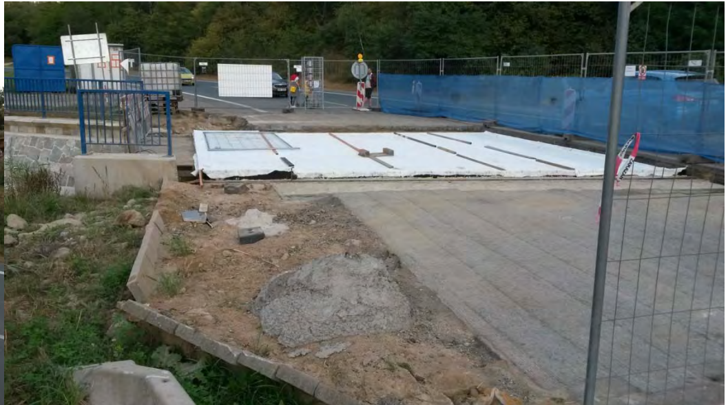
Na hrázi Žebětínského rybníka byla v polovině srpna zahájena oprava mostu přes potok Vrbovec. Stavba se realizuje po polovinách silnice.
