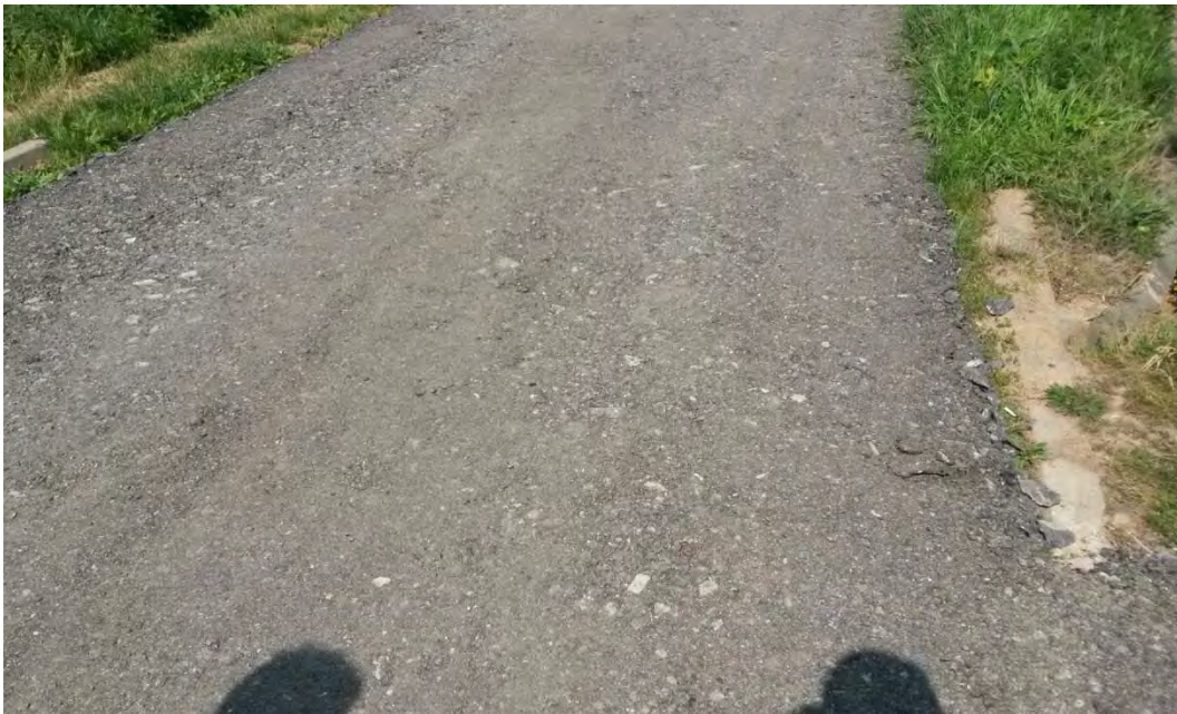
ÚMČ Žebětín přistoupila k opravám polních a účelových cest na svém katastru vrstevami vytěženého vydroleného asfaltu. Snímky jsou z polní cesty na bystrckém břehu (28.5.2016).
