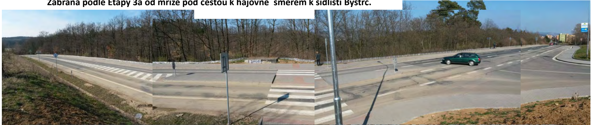
Zábrana podle Etapy 3a od mříže pod cestou k hájovně směrem k sídlišti Bystrc.
