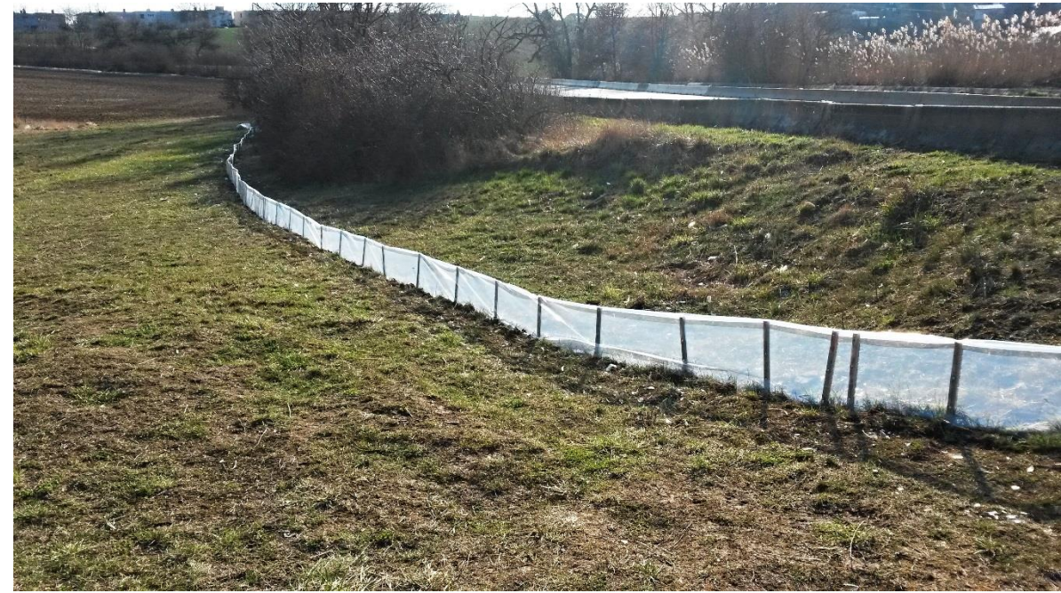
2. 4. 2018. Igelitové zábrany jsou instalovány pod hrází - větve C a B.
