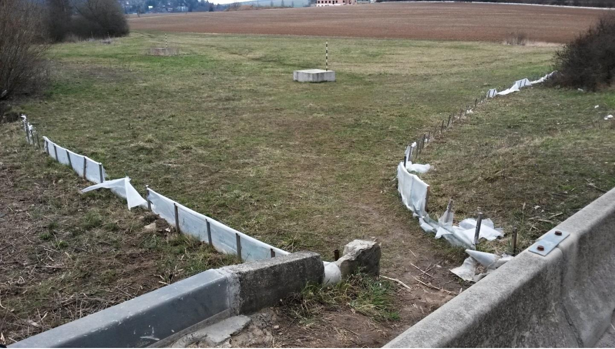
2. 4. 2018. Igelitové zábrany jsou instalovány pod hrází - větve C a B.
