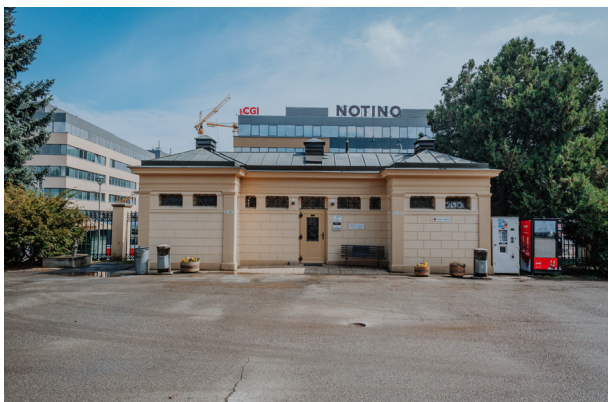
Pohled na veřejné WC u hlavního vstupu, 2021
