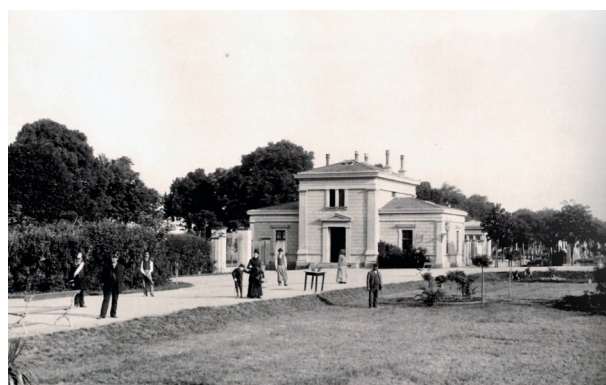
Pohled na vstupní předpolí Ústředního hřbitova se správním objektem od Aloise Prastorfera, fotografie před rokem 1918
