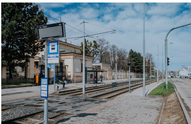
Pohled na tramvajové zastávky na Vídeňské, 2020
