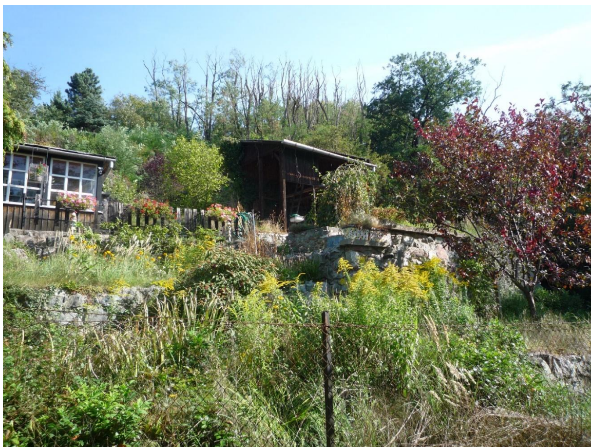
Přístřešek na pozemku p.č. 920 k.ú. Ivanovice
