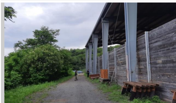
Pohled na halu od SZ
