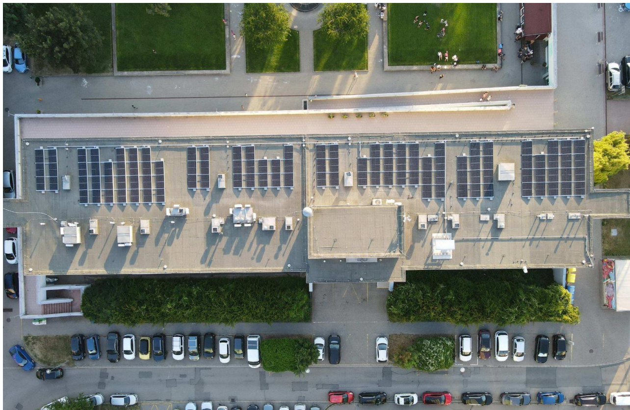
Obrázek 9: FVE Velkopavlovická 25 - dron fotodokumentace
