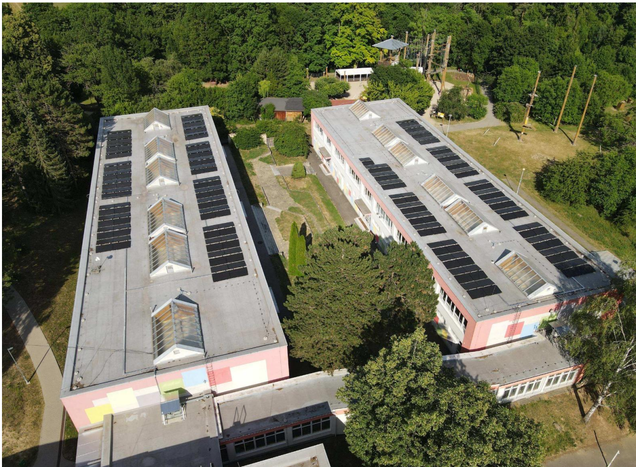
Obrázek 4: FVE ZŠ Milénova 14 - dron fotodokumentace
