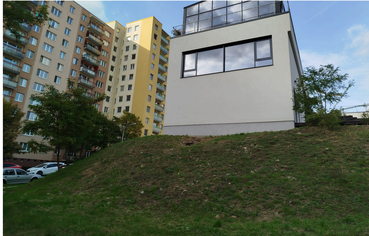
Holý svah pod objektem komunitního centra
