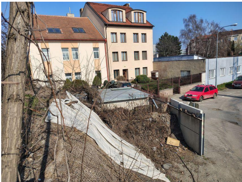
pohled na stavbu garáže s navážkou a oplocením
