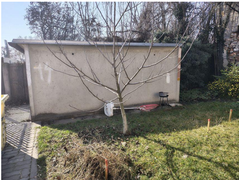
pohled na parcelu č. 791/3, k.ú, Trnitá se stavbou garáže
