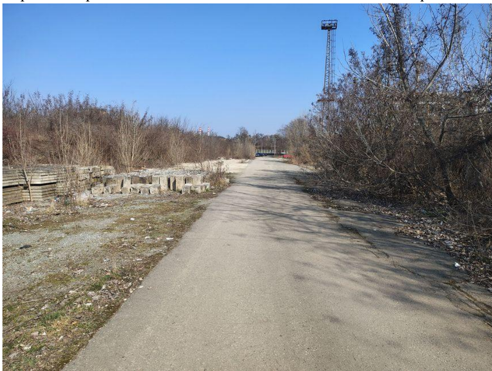
pohled na sousední parcelu č.768/3 - bývalý nákladová prostor nádrží ve vlastnictví společnosti České dráhy
