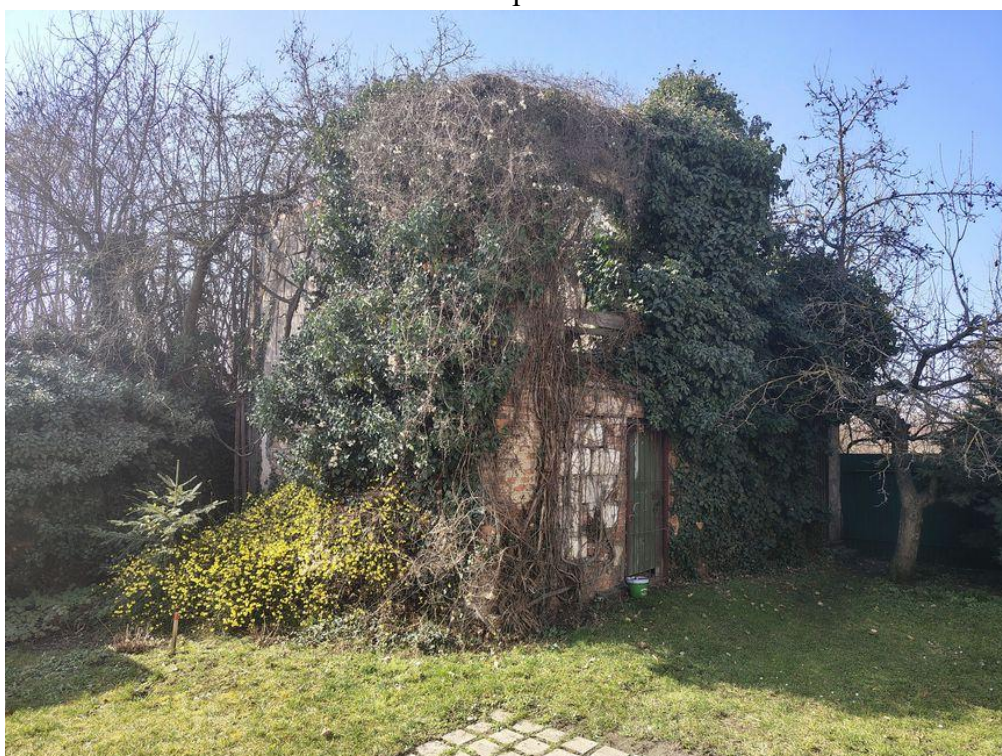
pohled na vedlejší stavbu nacházející se na parcele č.771/1, k.ú. Trnitá - předmětné území k rozdělení pozemku
