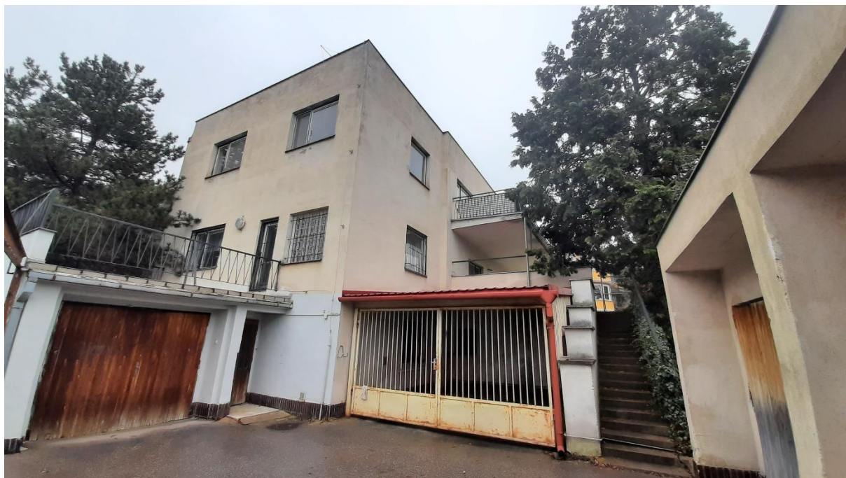
Pohled na budovu z bočního vjezdu
