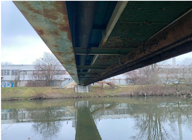
Podhled nosné konstrukce.
