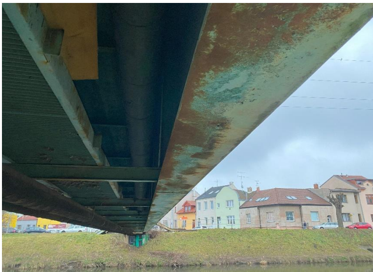
Pohled na hlavní nosník.
