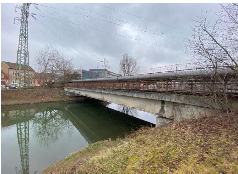
Pohled na most zprava (vtok).
