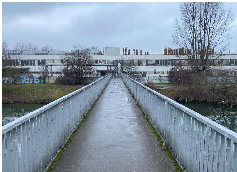
Pohled na lávku ve směru staničení.
