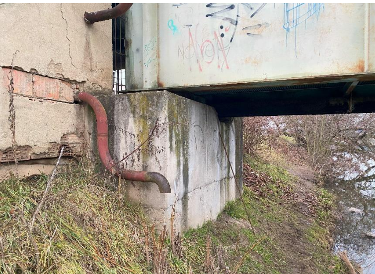
Pohled na OP2.
