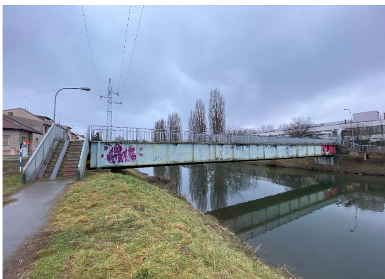
Pohled na lávku zprava (vtok).
