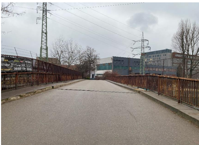
Pohled na most proti směru staničení.
