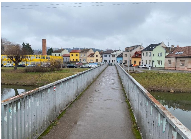
Pohled na lávku proti směru staničení.
