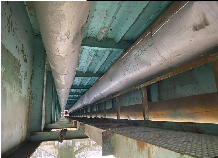
Pohled do prostoru lávky a na revizní lávku.
