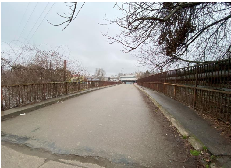
Pohled na most ve směru staničení.
