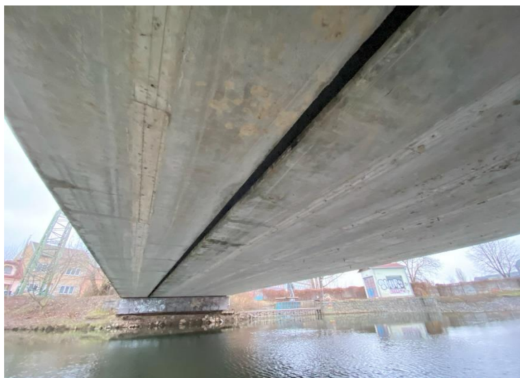
Podhled nosné konstrukce.
