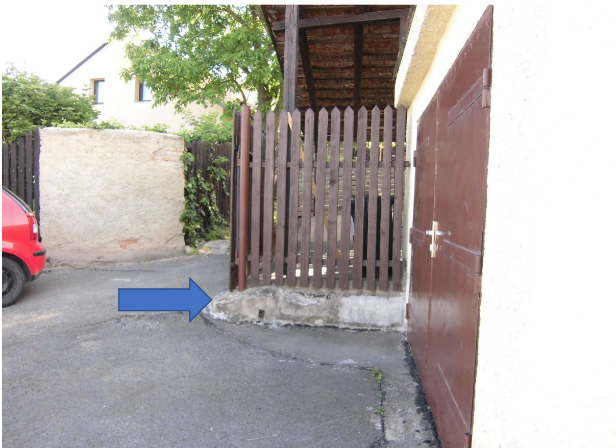
Část pozemku p.č. 2188/2 v k.ú. Černovice zastavěná přesahem parkovacího přístřešku
