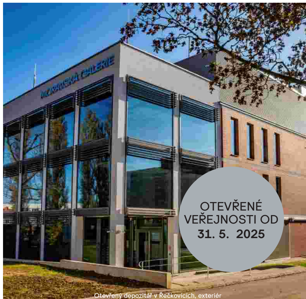
Otevřený depozitář v Řečkovících, exteriér
